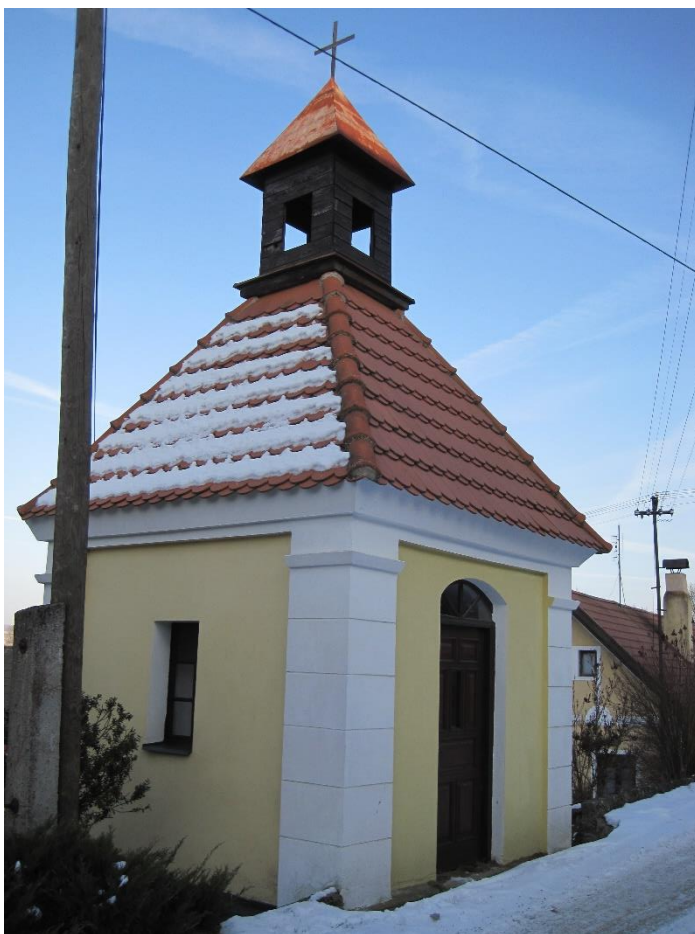
Kaplička se zvoničkou v obci Krasovice (zdroj autor)
