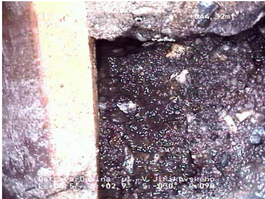
Obr. 33 Fotografie z kamerového průzkumu [OVAK a.s.]
