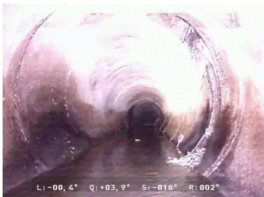
Obr. 49 Fotografie z kamerového průzkumu [OVAK a.s.]
