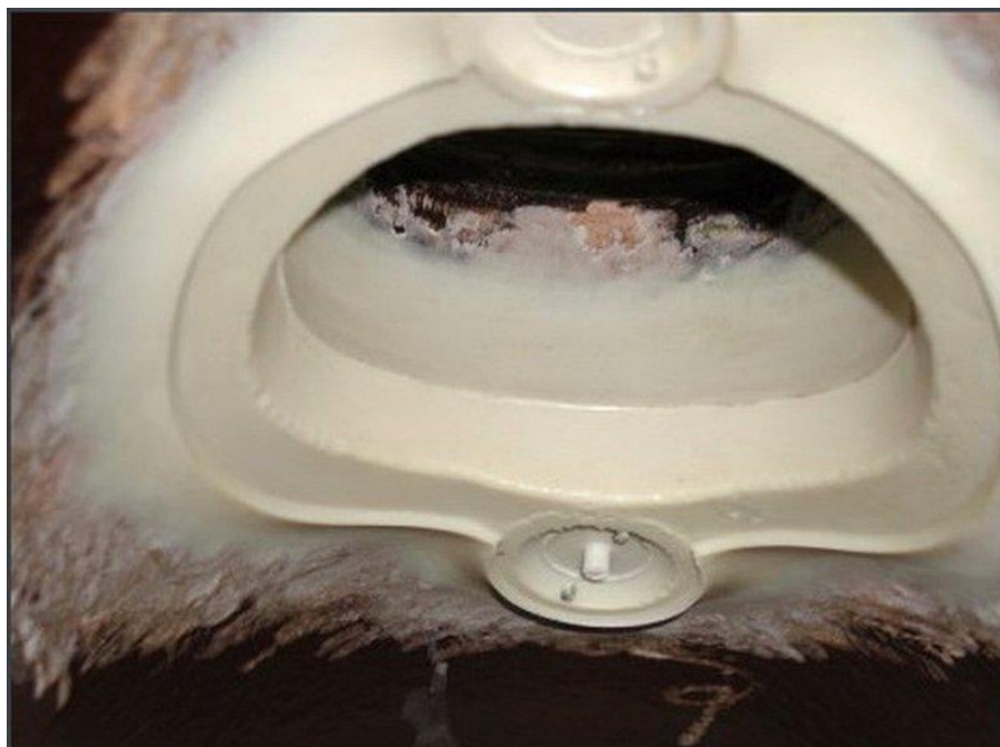
Obr. 20 Technologie KAWO injekt pro zapravení přípojek [27]
