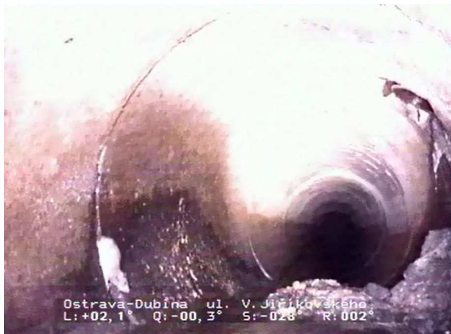
Obr. 48 Fotografie z kamerového průzkumu [OVAK a.s.]
