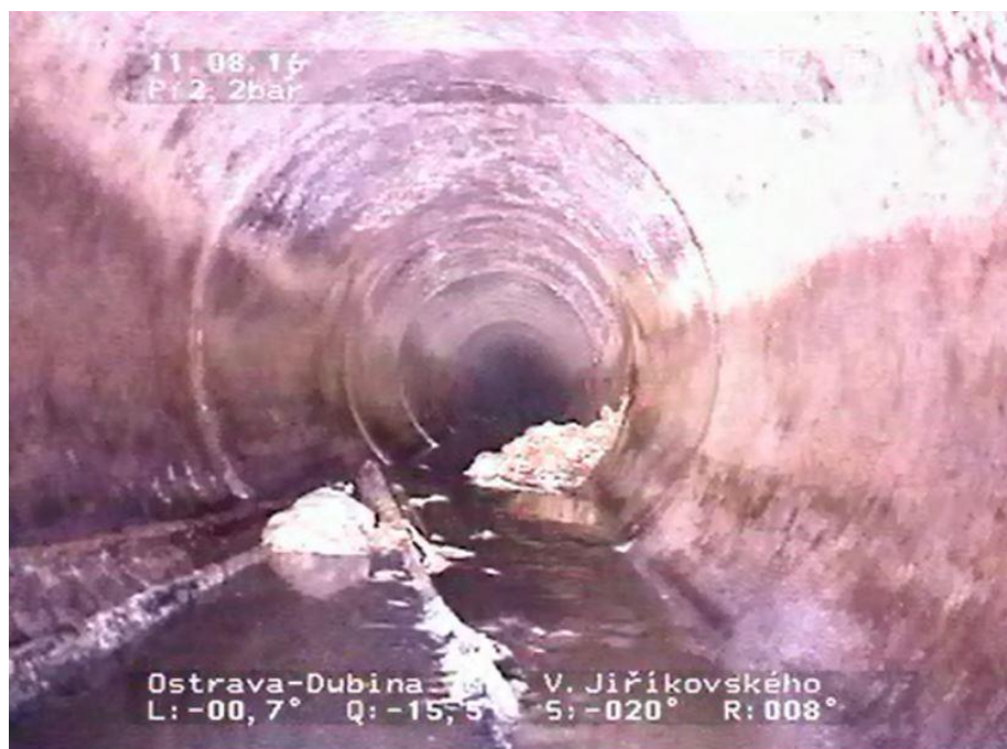
Obr. 44 Fotografie z kamerového průzkumu [OVAK a.s.]
