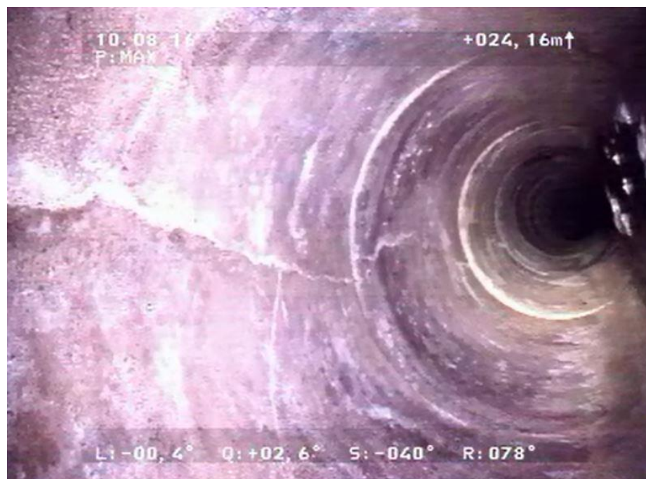
Obr. 40 Fotografie z kamerového průzkumu [OVAK a.s.]
