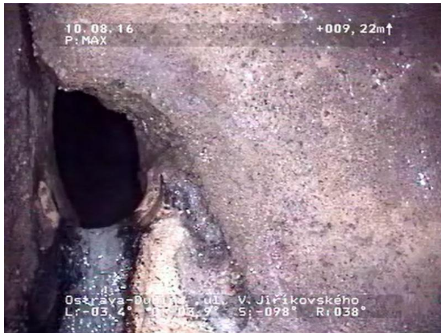
Obr. 39 Fotografie z kamerového průzkumu [OVAK a.s.]
