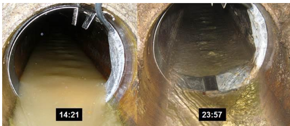
Obr. 22 Ukázka balastních průtoků v nočních hodinách [R. Komůrka]
