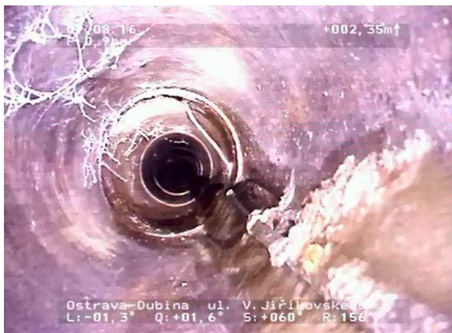
Obr. 28 Fotografie z kamerového průzkumu [OVAK a.s.]
