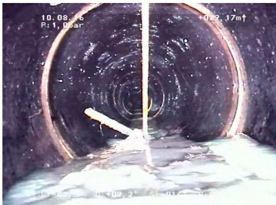
Obr. 36 Fotografie z kamerového průzkumu [OAVAK a.s.]
