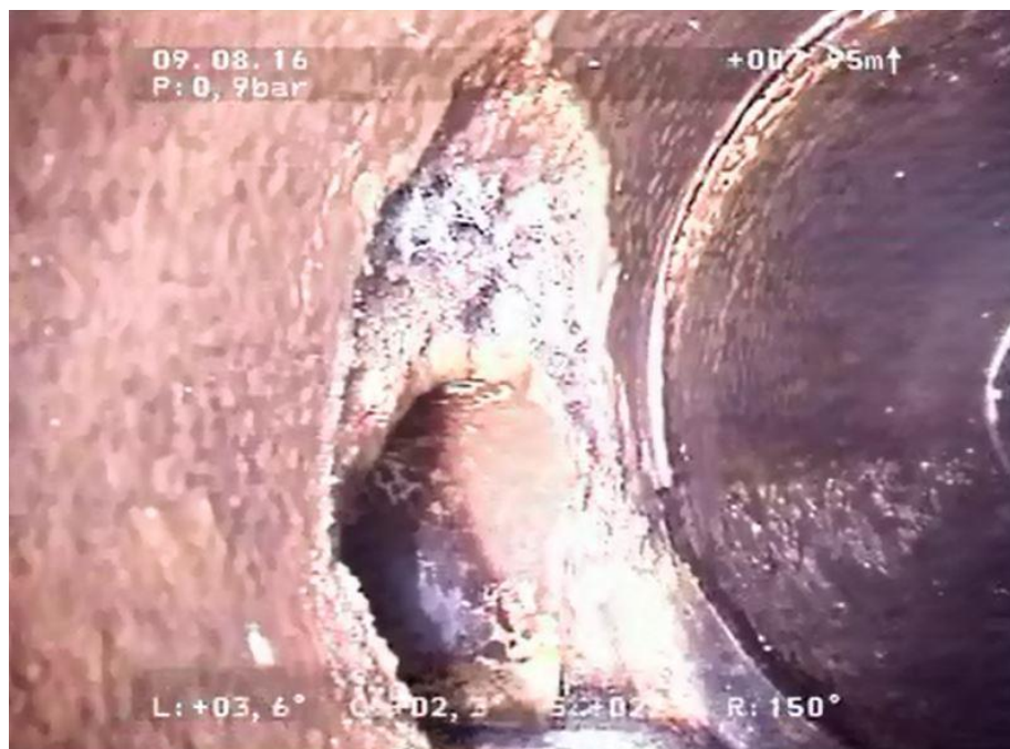
Obr. 32 Fotografie z kamerového průzkumu [OVAK a.s.]
