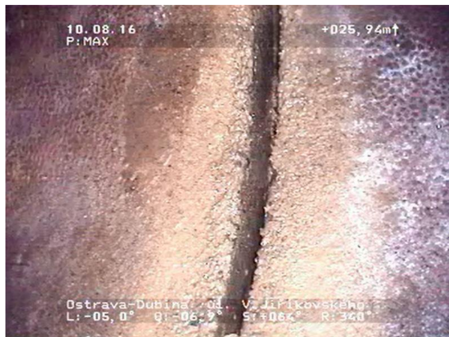
Obr. 42 Fotografie z kamerového průzkumu [OVAK a.s.]
