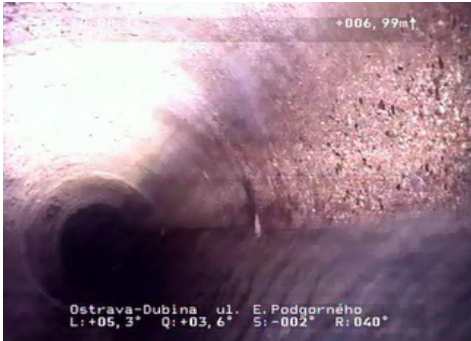
Obr. 38 Fotografie z kamerového průzkumu [OVAK a.s.]
