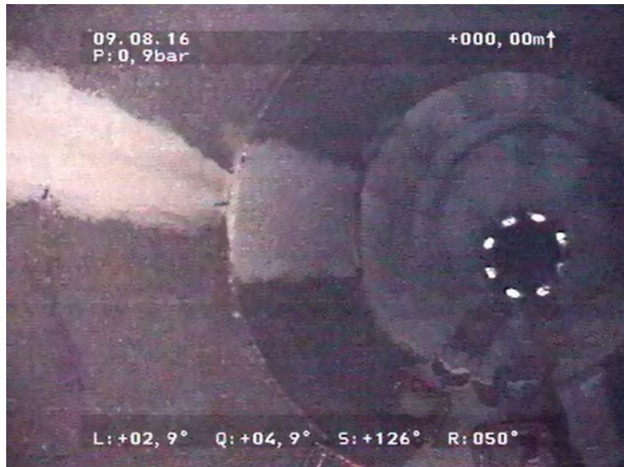
Obr. 50 Fotografie šachty č. 500765 [OVAK a.s.]
