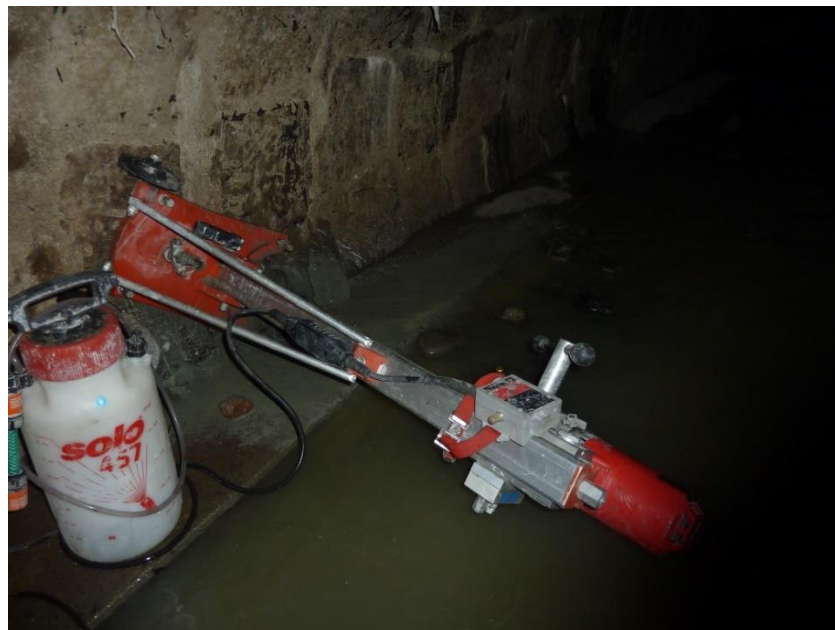
Obr. 9 Ukázkou jádrového vrtání ve stoce [L. Židek]
