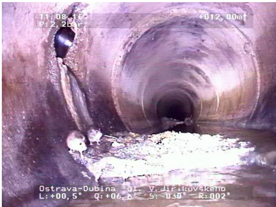
Obr. 47 Fotografie z kamerového průzkumu [OVAK a.s.]
