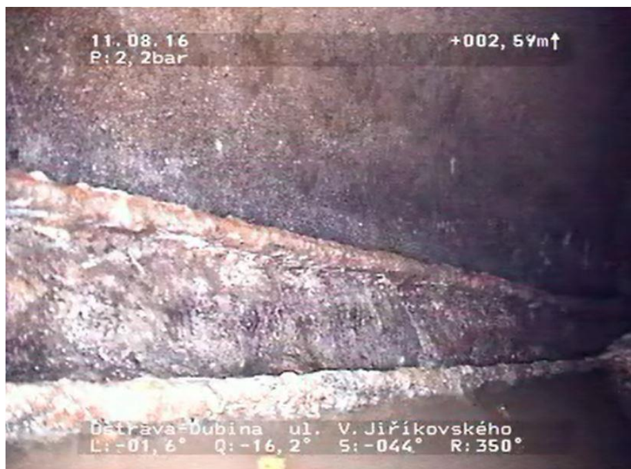
Obr. 43 Fotografie z kamerového průzkumu [OVAK a.s.]
