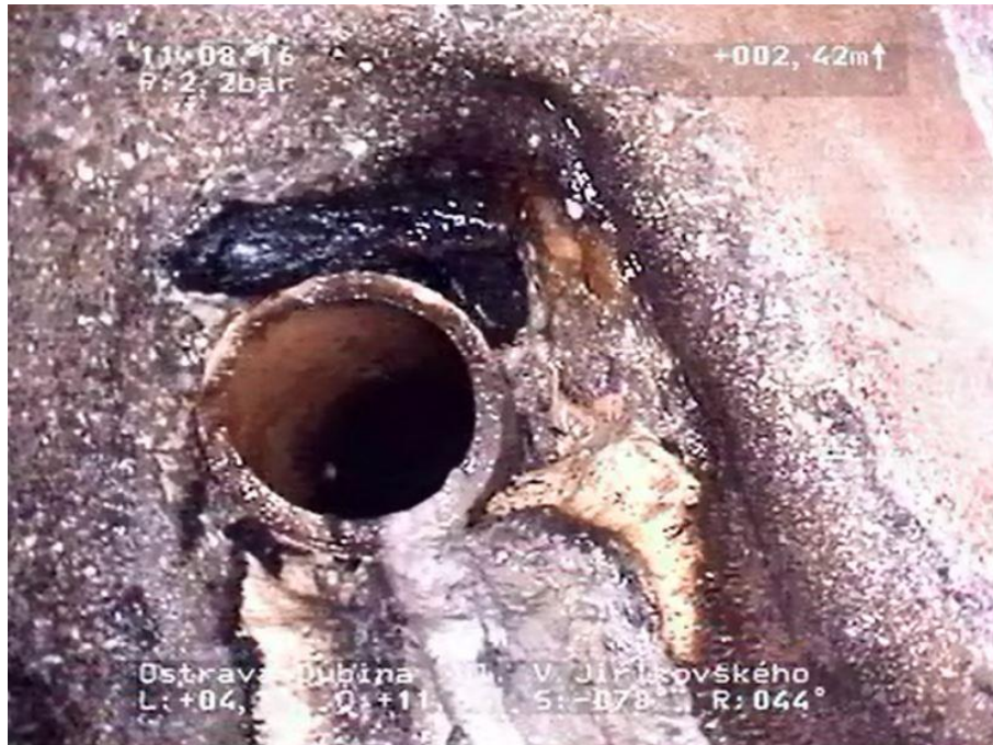
Obr. 46 Fotografie z kamerového průzkumu [OVAK a.s.]
