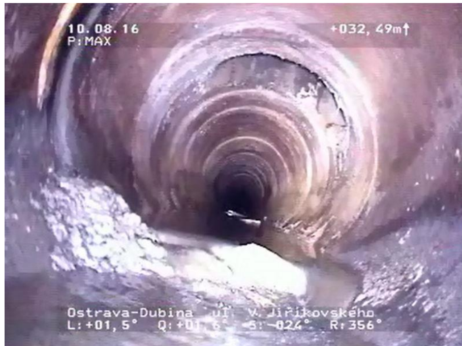
Obr. 41 Fotografie z kamerového průzkumu [OVAK a.s.]
