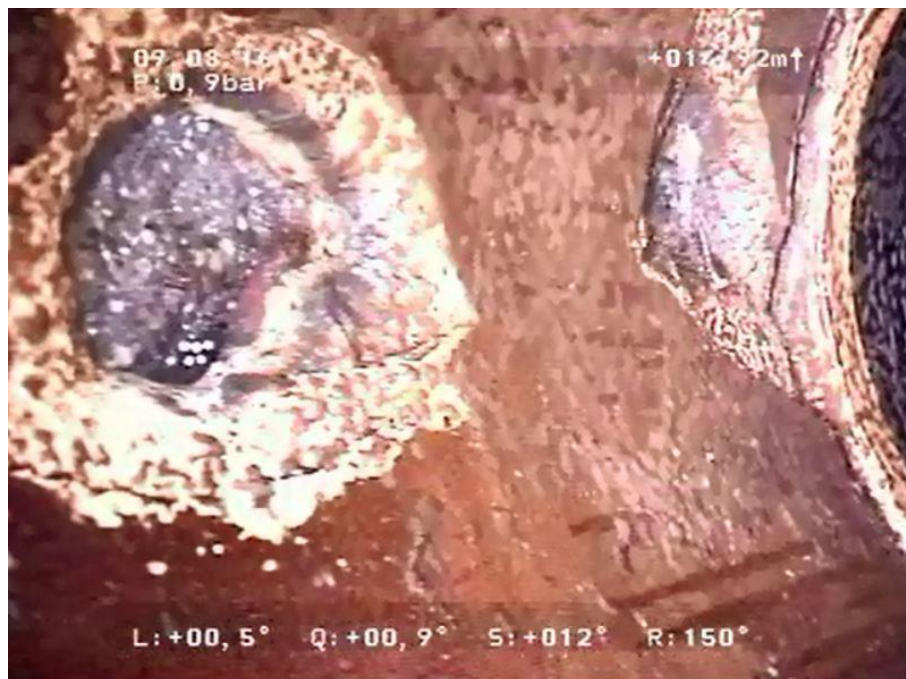
Obr. 34 Fotografie z kamerového průzkumu [OVAK a.s.]
