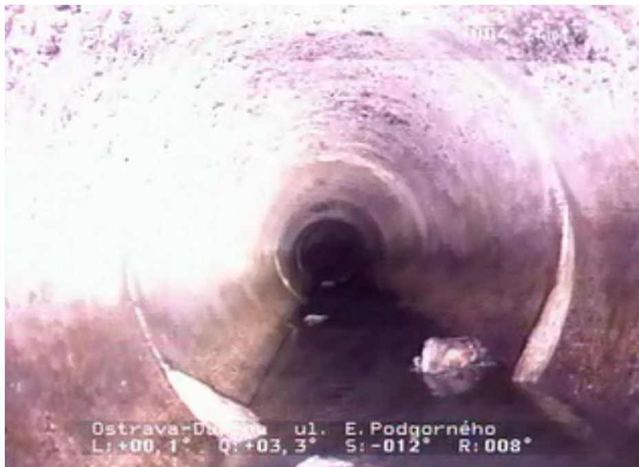
Obr. 37 Fotografie z kamerového průzkumu [OVAK a.s.]
