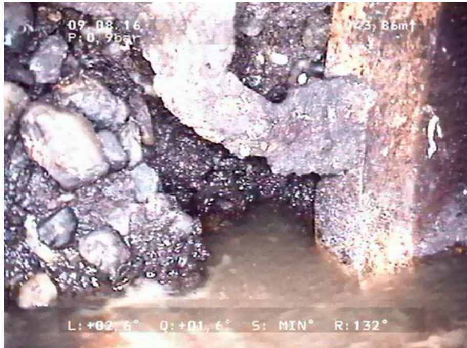
Obr. 29 Fotografie z kamerového průzkumu [OVAK a.s.]
