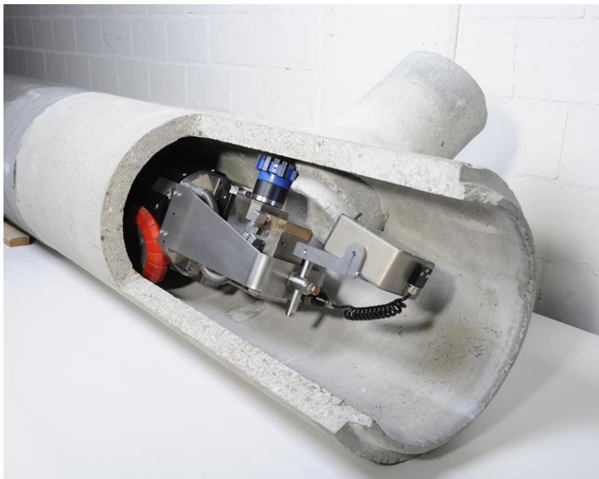
Obr. 19 Ukázka kanalizačního robota při frézování přesazené přípojky [28]
