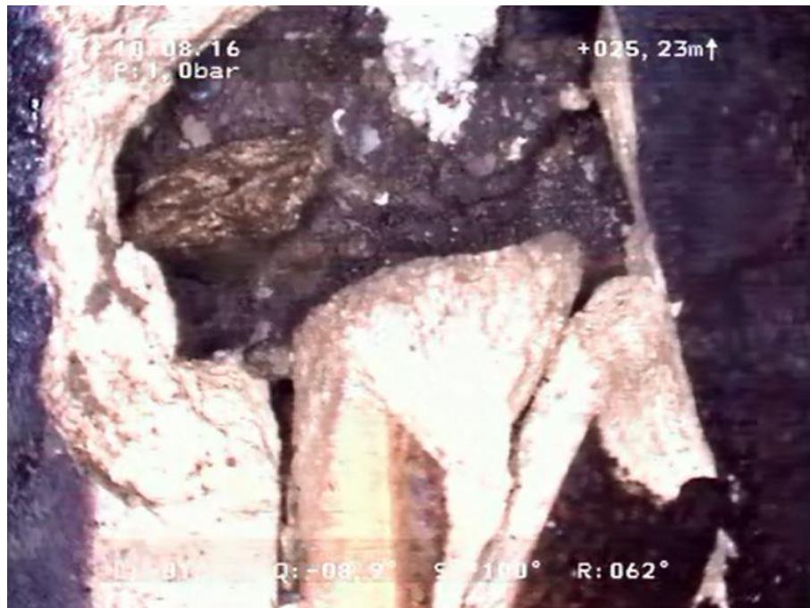
Obr. 35 Fotografie z kamerového průzkumu [OAVAK a.s.]
