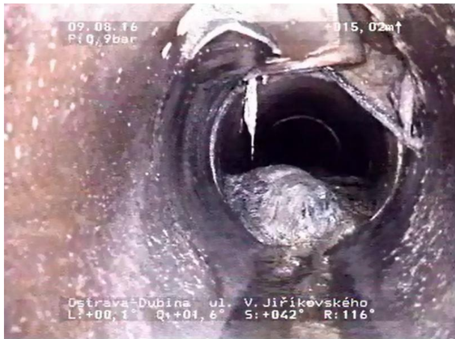
Obr. 26 Fotografie z kamerového průzkumu [OVAK a.s.]
