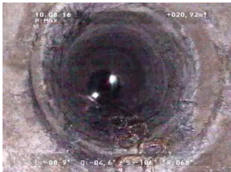
Obr. 51 Fotografie šachty č. 500719 [OVAK a.s.]
