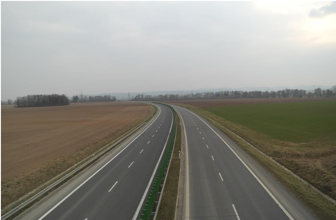
Příloha 2: První vybudovaný úsek přeložky silnice I/44 Postřelmov-obchvat
