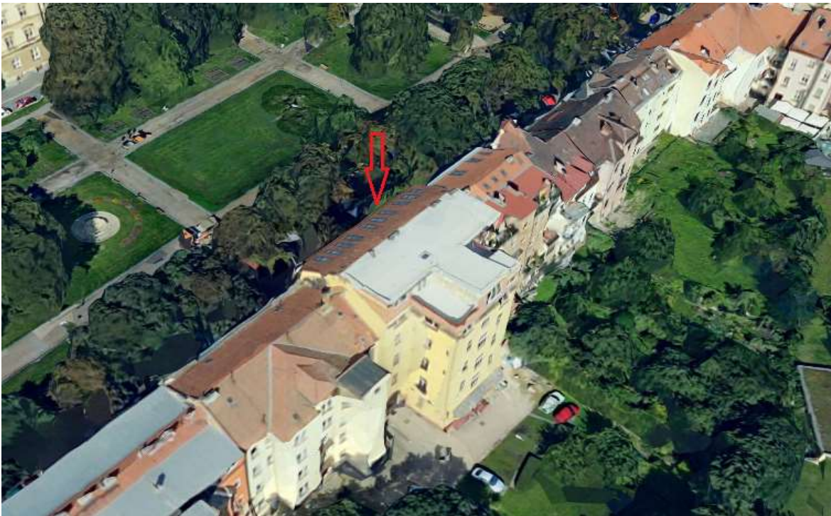
Obr. 6: Objekt Obilní trh 4-po nástavbě a vestavbě 5. a 6.NP, Brno-střed [mapy.cz]
