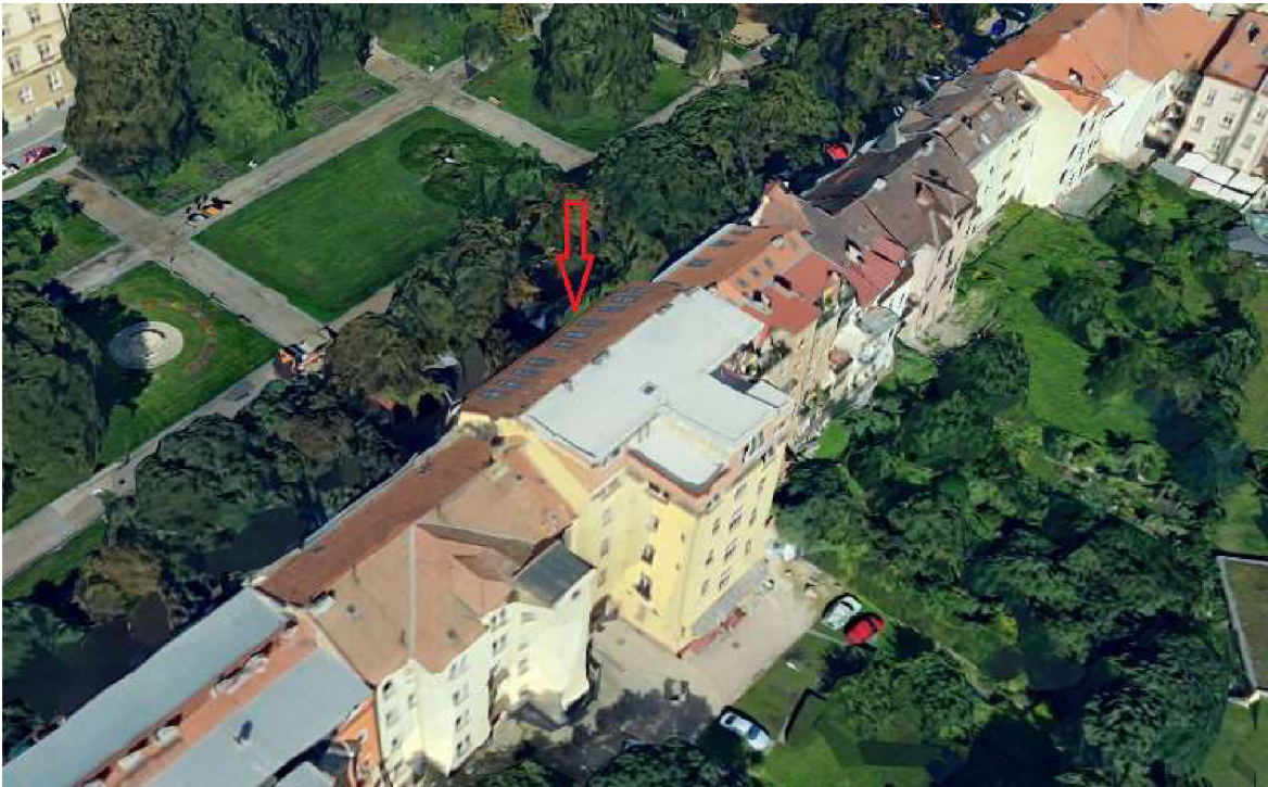
Obr. 6: Objekt Obilní trh 4-po nástavbě a vestavbě 5. a 6.NP, Brno-střed [mapy.cz]
