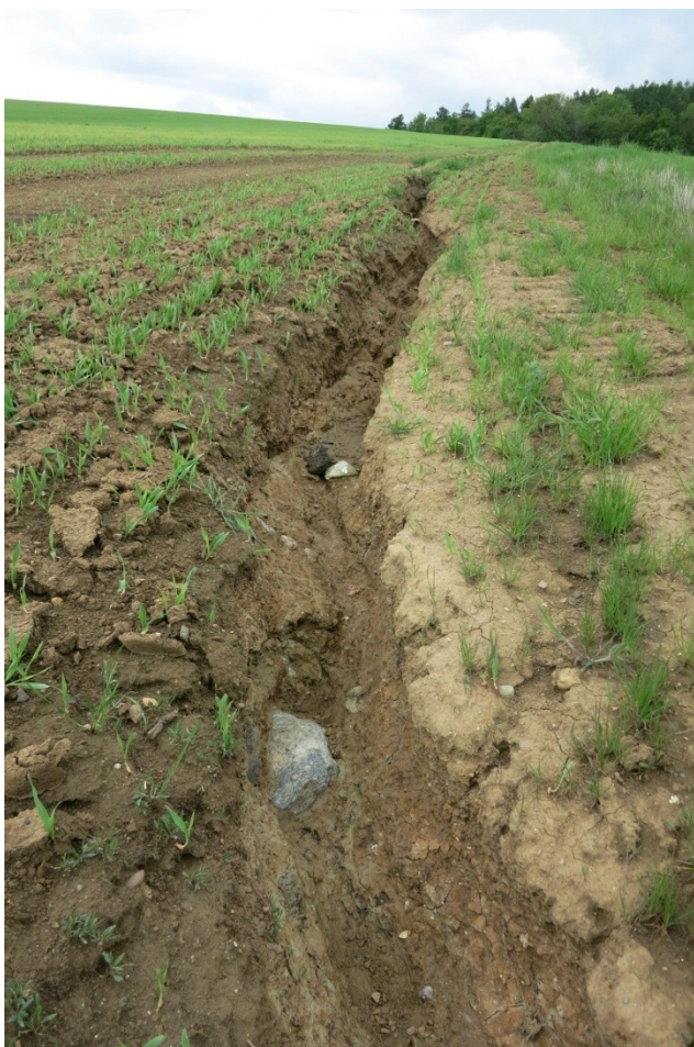
Obr. 23: Erozní rýha na půdním bloku 2003 (Monitoring eroze zemědělské půdy)
