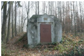
Obr.63: historický vodojem v Libavském Údolí (foto autor)
