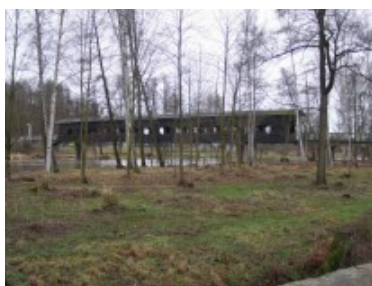
Obr.53: dřevěná lávka přes Ohří (foto autor)
