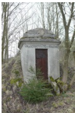
Obr.64: historický vodojem v osadě Kolová (foto autor)
