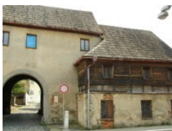
Obr. 31: Městská branka s domem č.p.9 (foto autor)
