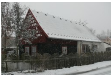
Obr.67: hrázděnka (foto autor)
