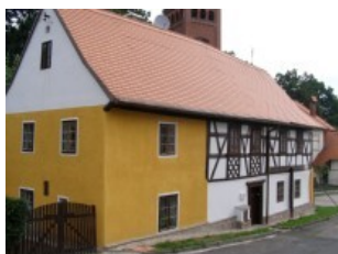
Obr. 32: hrázděnka (foto autor)
