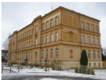
Obr.52: budova školy (foto autor)
