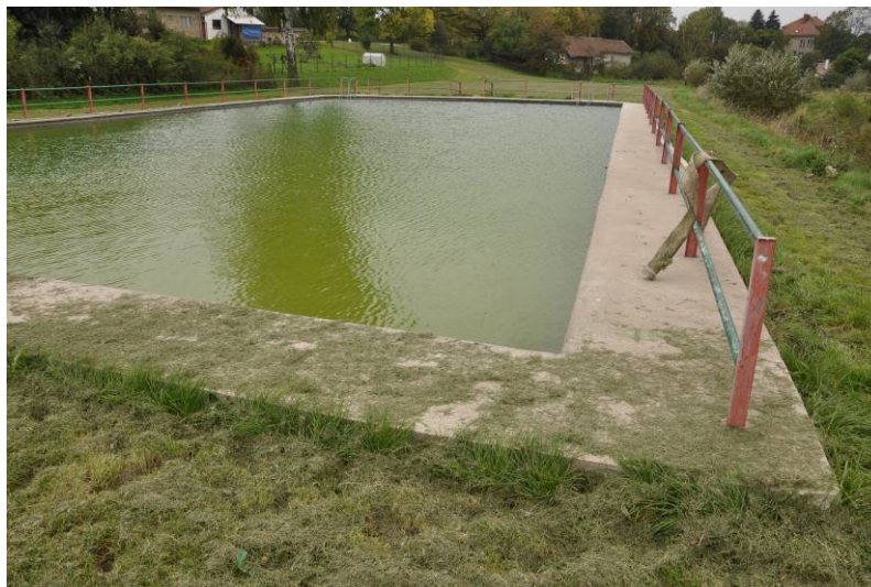
Foto č. 12 – Staré koupaliště po vyčištění. Zdroj: Linda Šviráková (3/2011).
