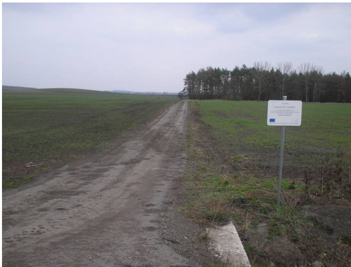
Foto č. 1 - Nově postavená cesta. Zdroj: Linda Šviráková (3/2011).
