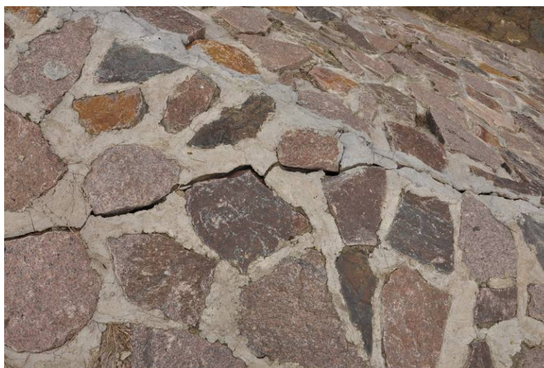
Foto č. 5 – Detail místního lomového kamene, který byl použit na stavbu vodní nádrže. Zdroj: Linda Šviráková (10/2010).
