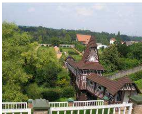
Obr. 116 Dřevěný zastřešený most
