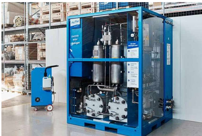
Obrázek 8 PEM elektrolýza vody [24]
