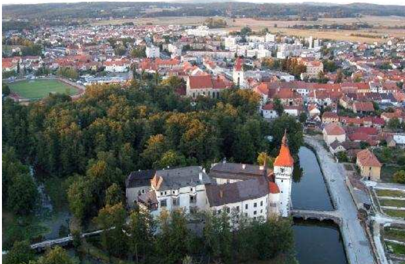
Obr. 19 Blatná z výšky (s dominantami zámku a věže)
