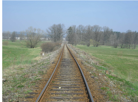
Obr. 24 Železniční trať Blatná-Strakonice
