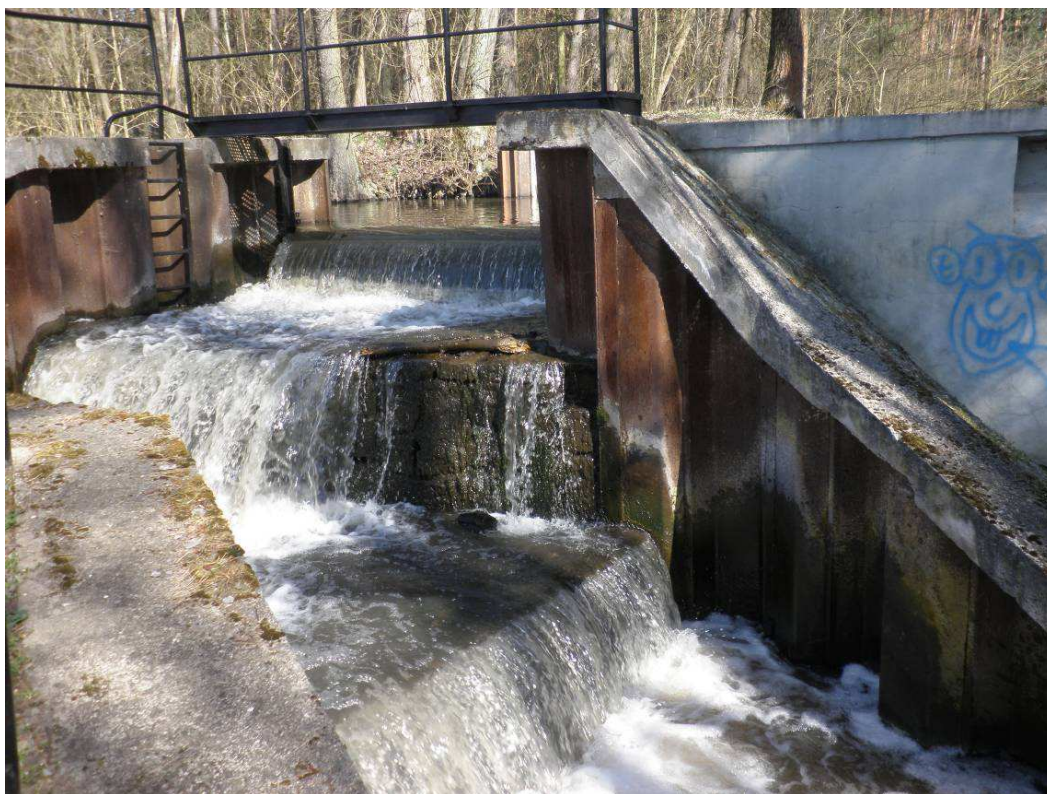
Obr. č. 16 mimoúrovňový akvadukt v obci Semín (foto: autor, 2013)
