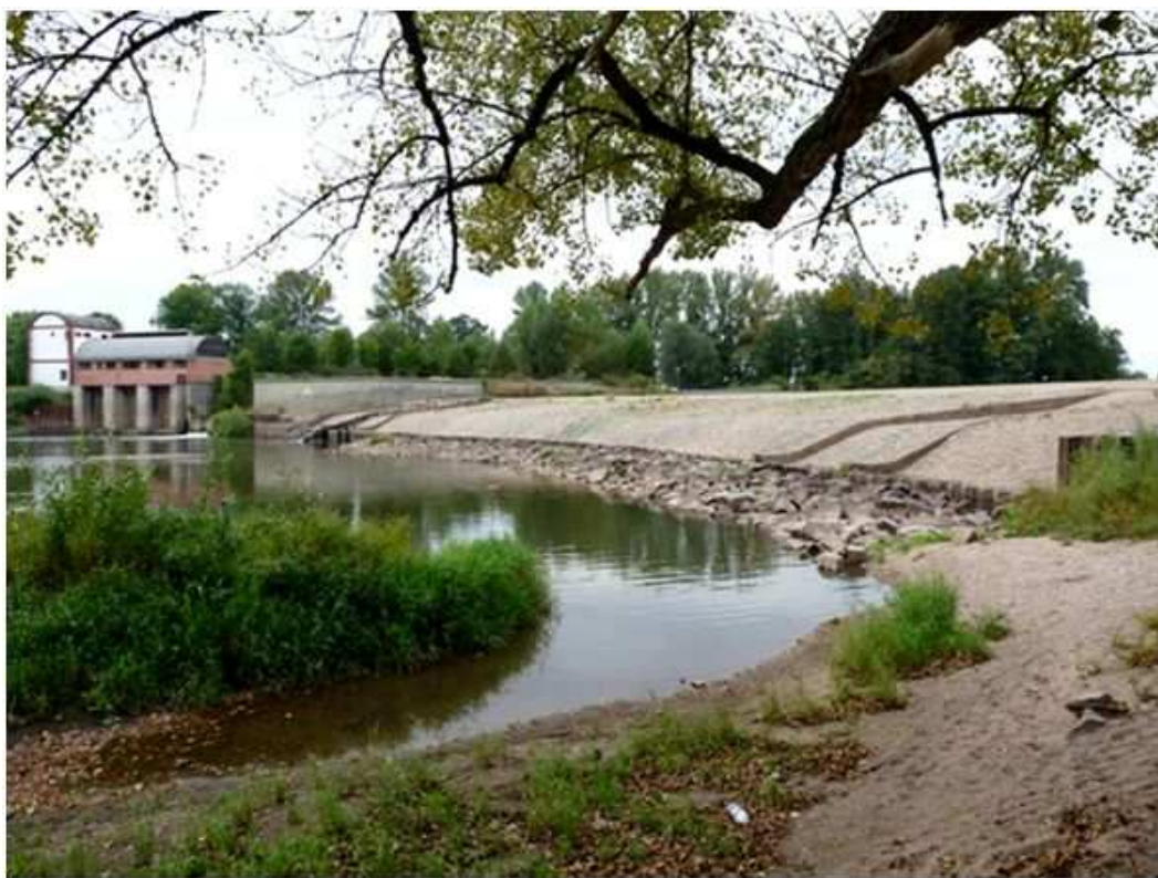
Obr. č. 14 Opatovický labský jez s malou vodní elektrárnou (foto: J. Půlpán)
