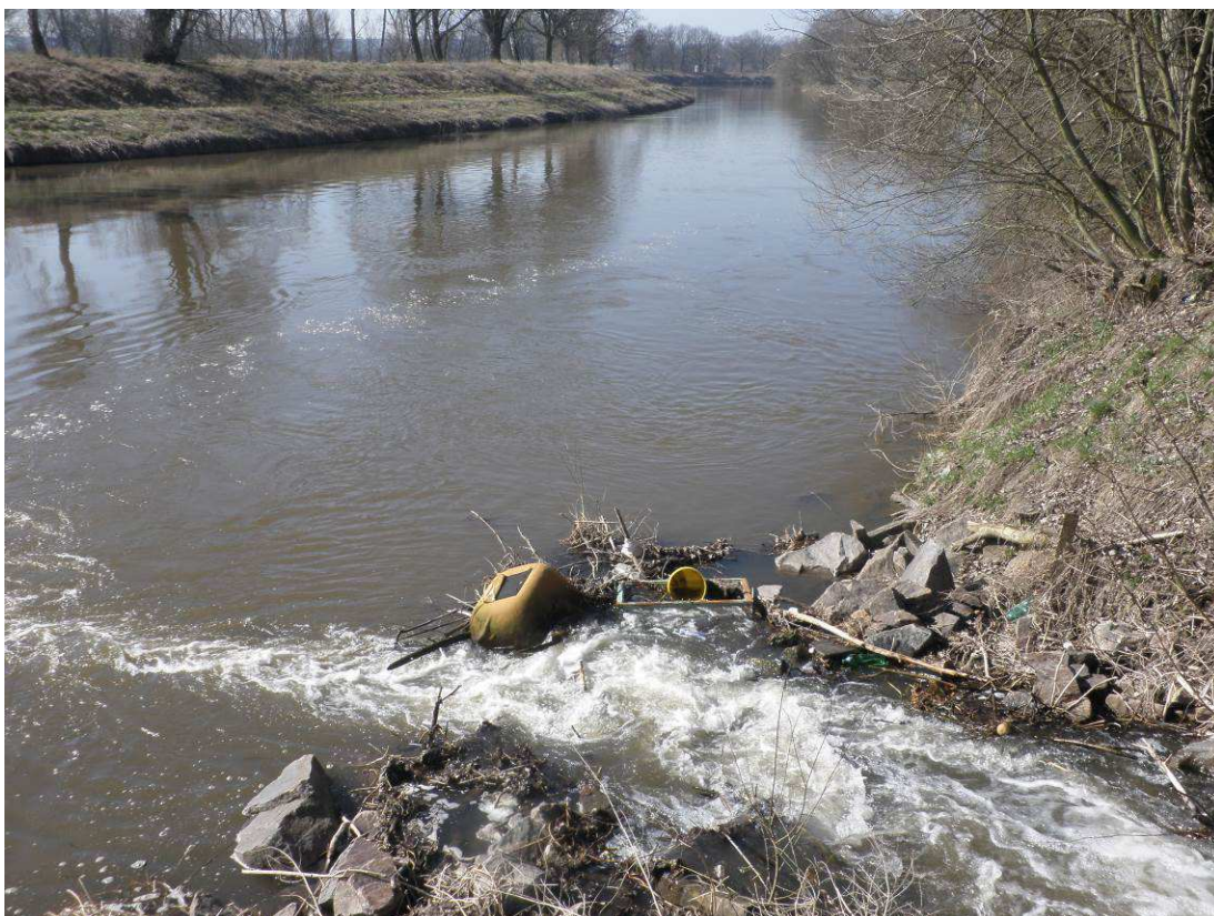
Obr. č. 18 současný stav zaústění Opatovického kanálu do Labe (foto: autor, 2013)
