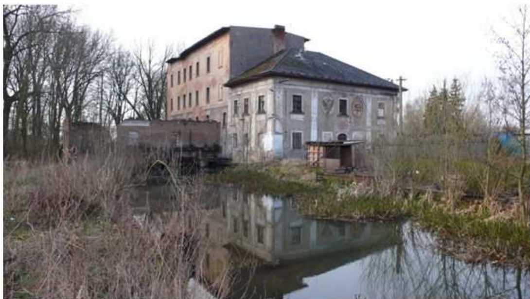
Obr. č. 26 Mlýn čp. 48 s nynějším zahradnictvím (foto: Chudý, 2008)
