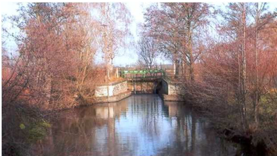
Obr. č. 27 ždánická stavidla (foto: Chudý, 2008)
