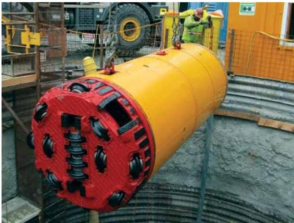
Obr. 4.3 Mikrotunelovací štít súpravy Herrenknecht AVN [15]
