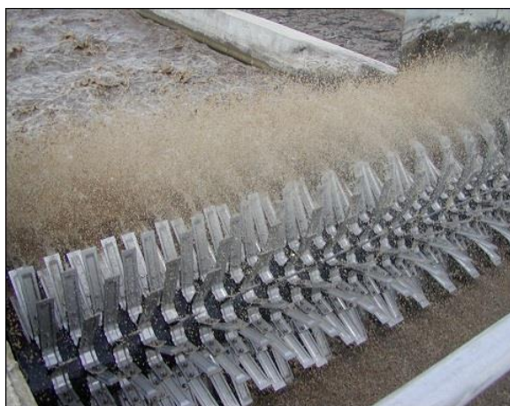
Obr. 4. – Povrchový horizontální aerátor [8]
