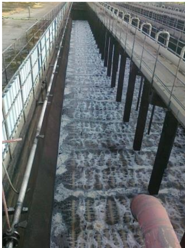
Foto č.5 a č.6 – Zkušební aerace před uvedením do provoz
