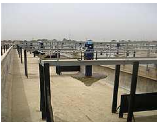
Obr. 2. - Povrchový vertikální aerátor [6]
