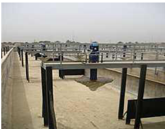
Obr. 2. - Povrchový vertikální aerátor [6]
