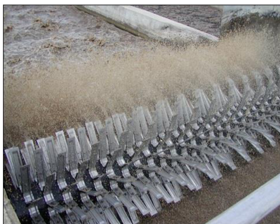
Obr. 4. – Povrchový horizontální aerátor [8]
