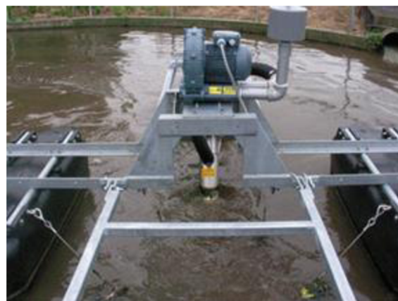
Obr. 3. – Povrchový aerátor na plovoucím zařízení [7]
