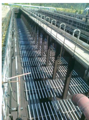
Foto č.4 – Finální stav po instalaci aeračních elementů OTT-Magnum
