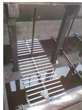
Foto č.3 – Instalace OTT-Magnum
