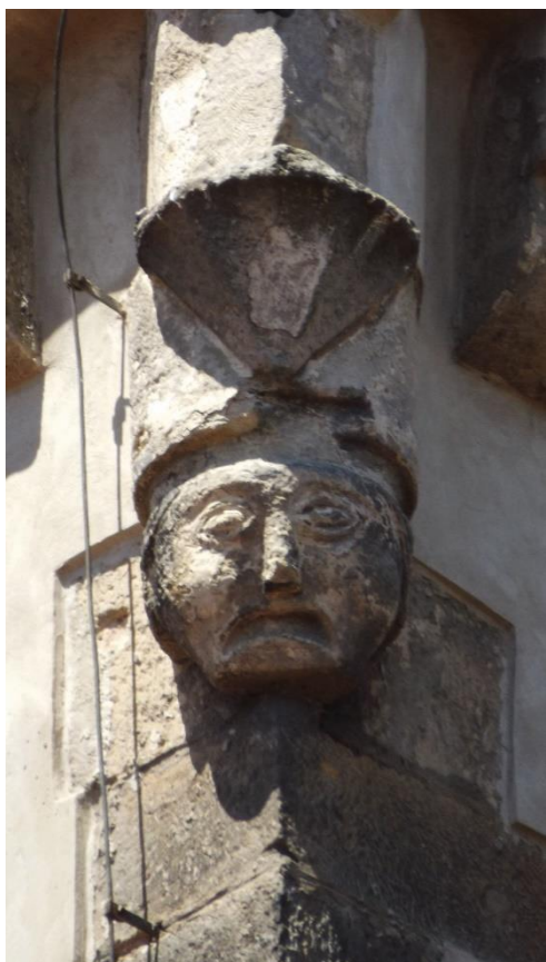
36. Nový Bydžov, kostel sv. Vavřince, jeden ze čtyř kamenných maskaronů v nároží zvonového patra věže s válcovou příporou a polygonální konzolou – jihovýchodní nároží
