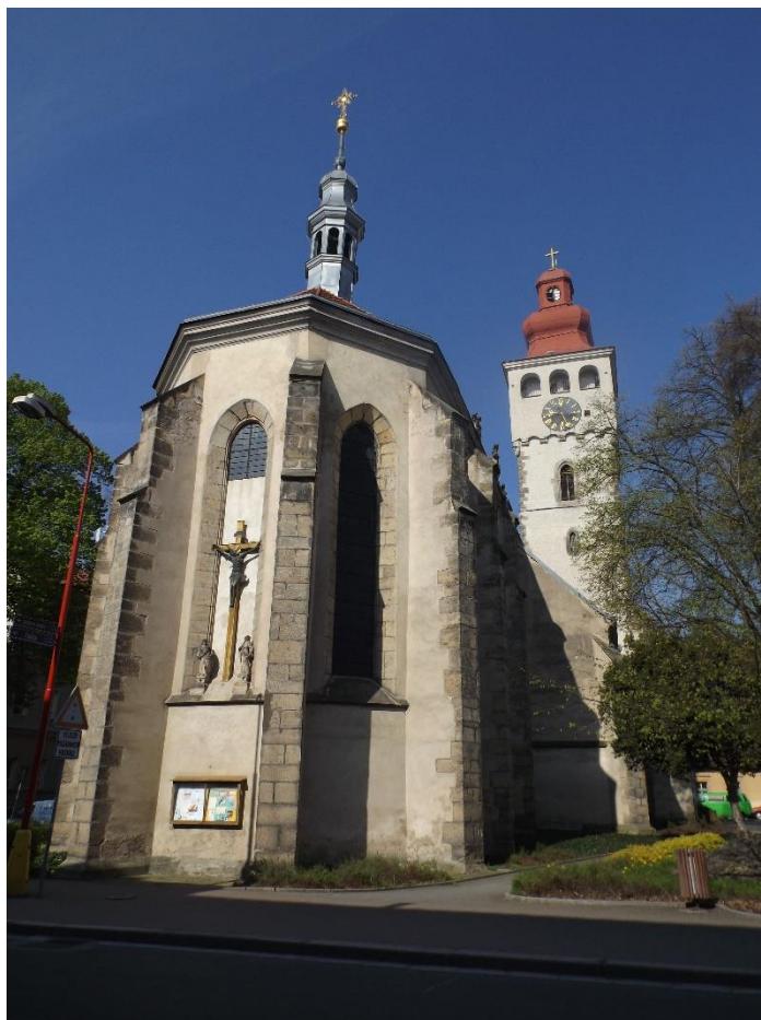
13. Nový Bydžov, kostel sv. Vavřince, presbytář s pětibokým závěrem a odstupněnými opěráky, pohled z východu
