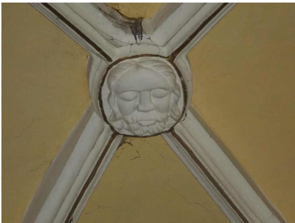
18. Nový Bydžov, kostel sv. Vavřince, svorník druhého klenebního pole od západu v hlavní lodi
