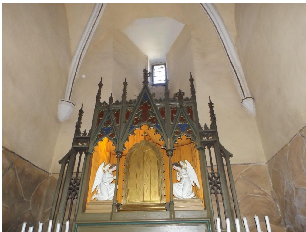
35. Nový Bydžov, kostel sv. Vavřince, podvěží s křížovou klenbou a částečně zalděným gotickým hrotitým oknem
