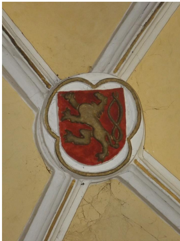
17. Nový Bydžov, kostel sv. Vavřince, svorník nejzápadnějšího klenebního pole hlavní lodi
