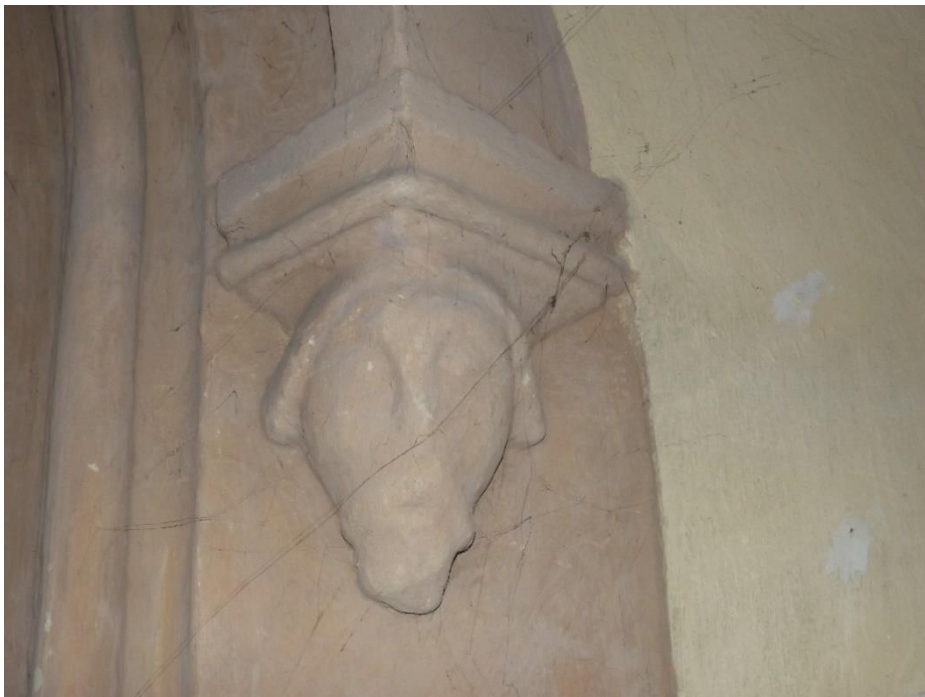
29. Nový Bydžov, kostel sv. Vavřince, pravá konzola portálu v jižní předsíni v podobě římsy a lidské hlavy
