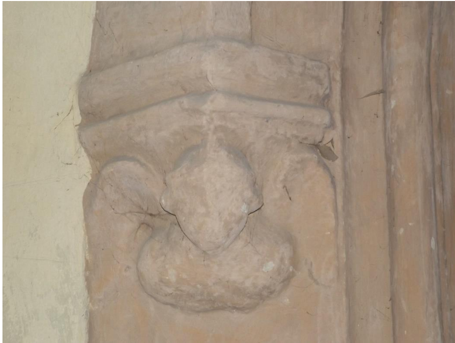
28. Nový Bydžov, kostel sv. Vavřince, levá konzola portálu v jižní předsíni v podobě římsy s poprsím anděla
