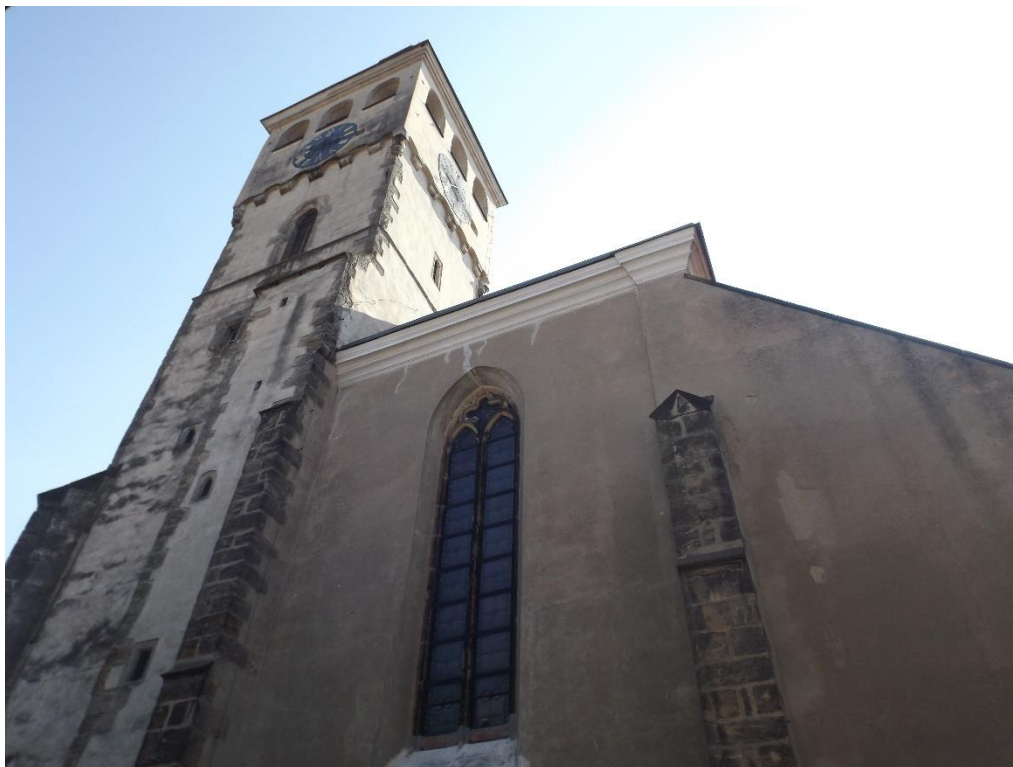
34. Nový Bydžov, kostel sv. Vavřince, okno západního průčelí nad portálem s nepůvodní kružbou, hranolová věž s dvěma novějšími horními patry, opěrné pilíře
