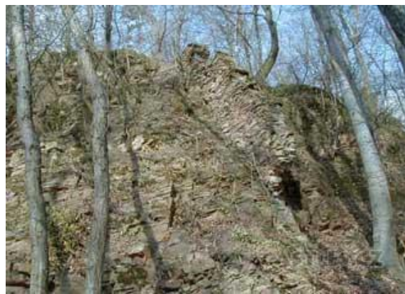
Obr. 9 - Relikt zdiva uzavírající šíjový příkop (www.castles.cz 2014)
