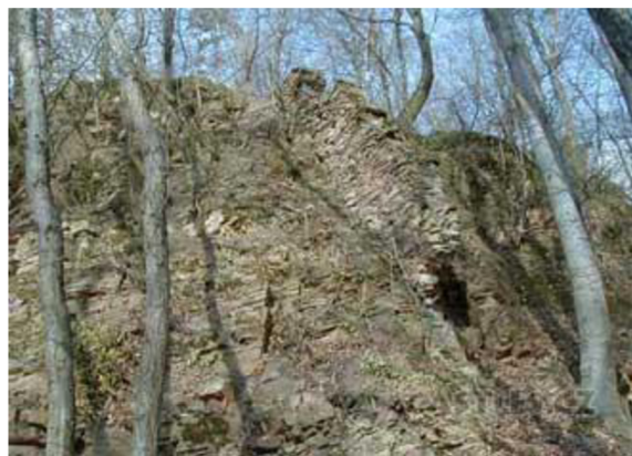
Obr. 9 - Relikt zdiva uzavírající šíjový příkop (www.castles.cz 2014)
