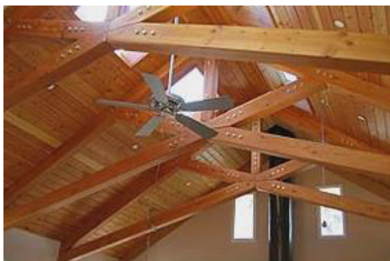
Obr. 11, Nosníky dřeva douglasky tvořící nosnou konstrukci střechy (Anon. 2015)
