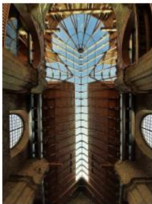
Prosklená střecha ve tvaru kříže.
