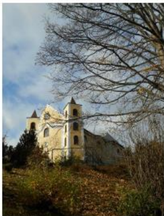
Podoba kostela s provizorním zastřešením věží (2017).
