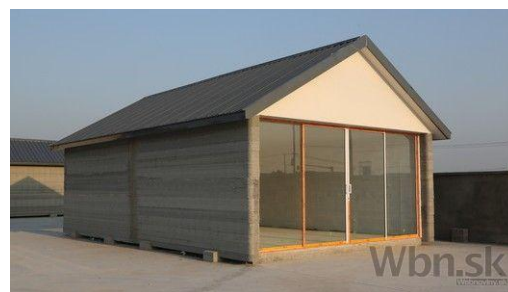
Obr. 3.1-7 3D tlačný dom z betónu [9]
