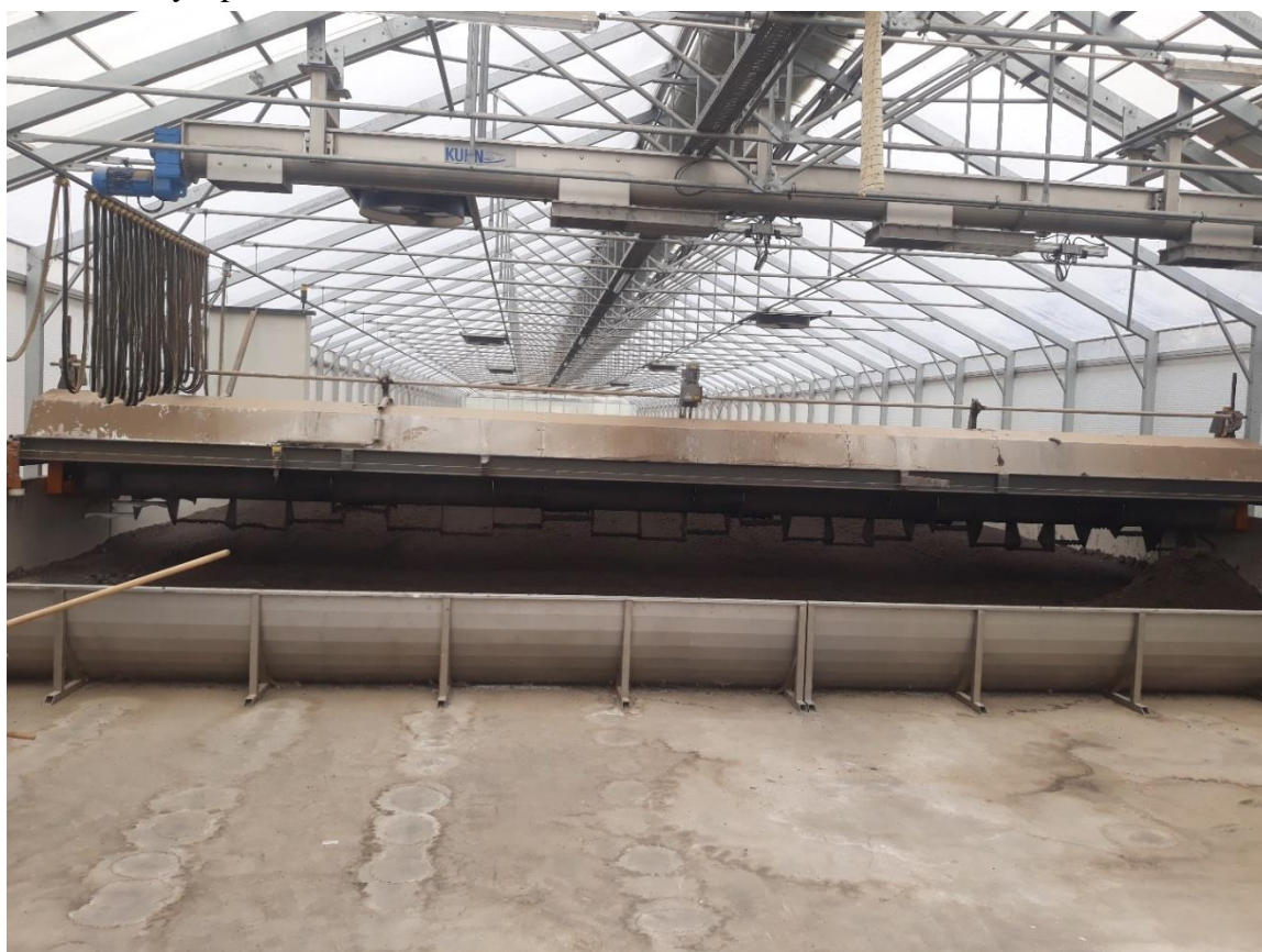
Obr. 18: Vnitřní prostor solární sušárny s přeřabovacím zařízením
