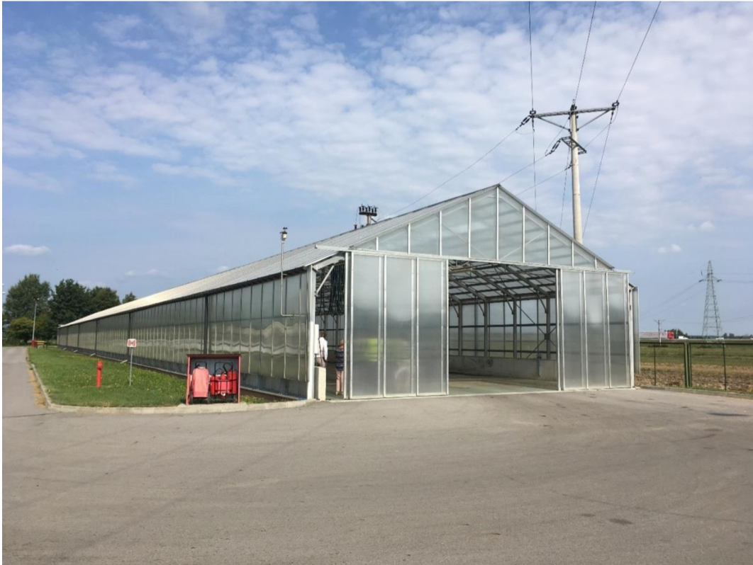
Obr. 19: Solární sušárna na ČOV ve městě Lancut v Polsku
