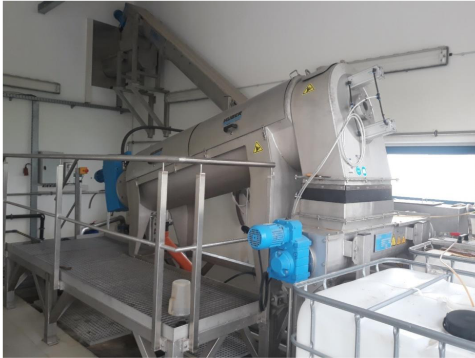
Obr. 12: Šroubový lis používaný na odvodnění kalu před vstupem do solární sušárny
