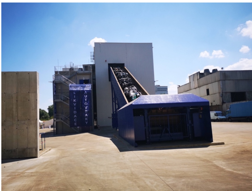
Obrázek 10 - Pohled na drtič se vstupním odpadem 131
