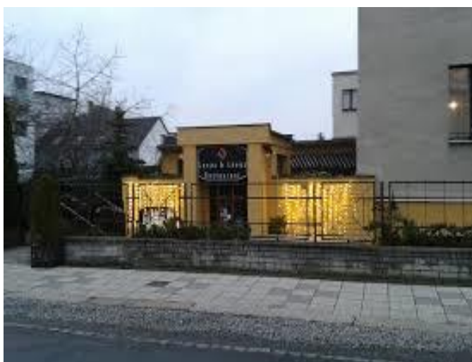
Foto č. 2 – exteriér budovy
