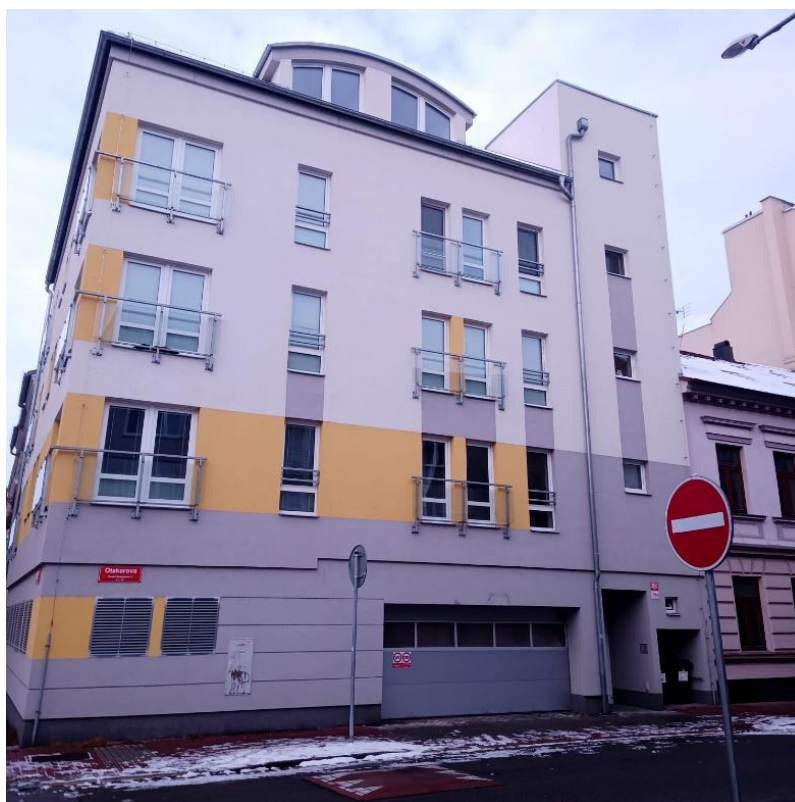
Obr. č. 2: Příklad nové výstavby v Otakarově ulici
