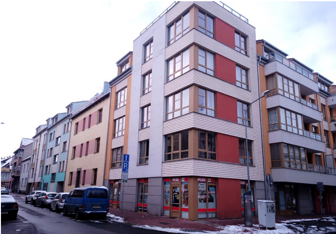
Obr. č. 3: Vyvýšení a převis prvního patra
