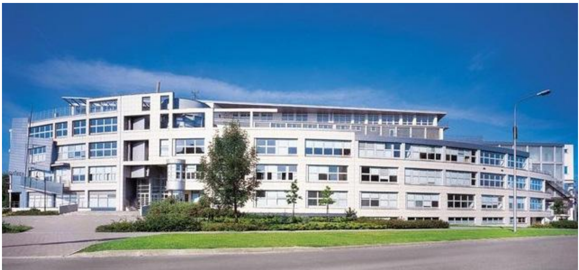
Obr. č. 1 - Výchozí objekt - gymnázium Orlová - Lutyně
