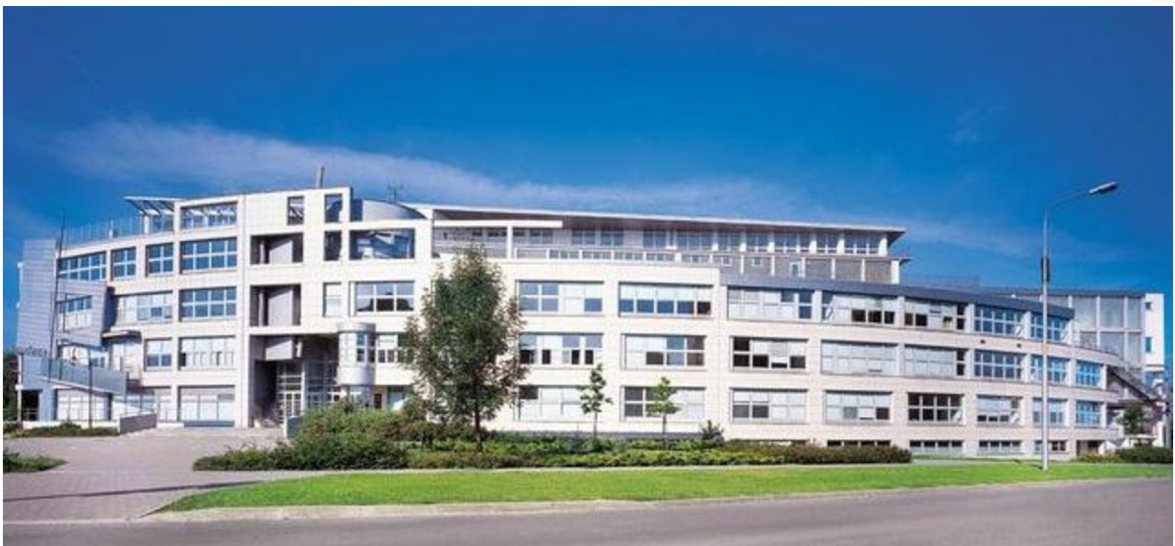
Obr. č. 1 - Výchozí objekt - gymnázium Orlová - Lutyně
