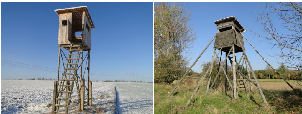
Obr. 10 Typická kazatelna s průběžnými stojinami.
