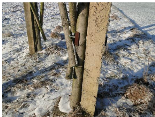
Obr. 26 „Obutí“ z železobetonu.
