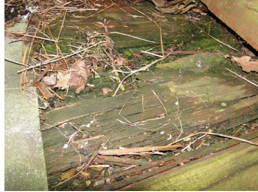
Příloha 28 a 29 Kazatelna a její podlaha za hranicí životnosti (č. 5 v honitbě Stružinec).
