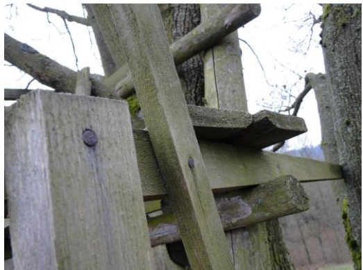
Příloha 36 a 37 Starší zařízení přesto bez patrné hniloby (č. 14 ve Stružinci)
