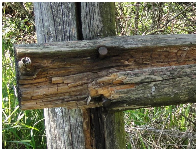
Obr. 29 Kostkovitý rozpad dřeva charakteristický pro celulózovorní houbou.
