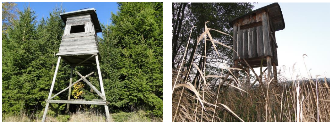
Obr. 32 a 33 typické šednutí neošetřeného dřeva vzniklé působením UV záření a dešťové vody.
