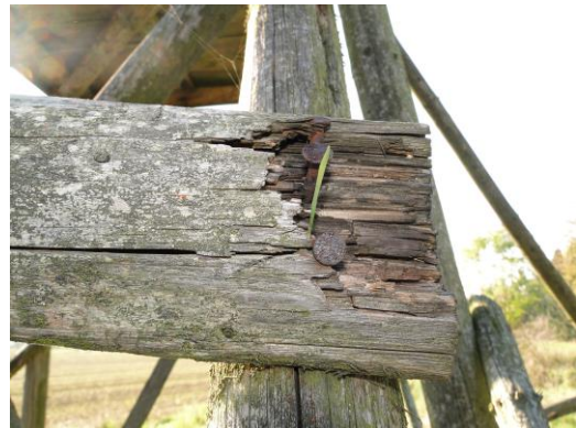
Příloha 26 a 27 Kazatelna č. 37 v Libštátě a detail destrukce příčky žebříku.
