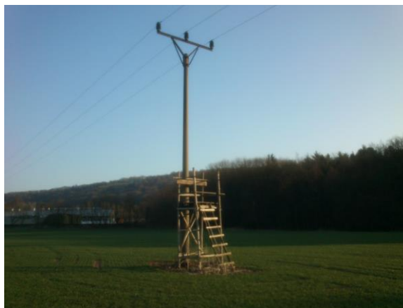
Obr. 36 Nepovolené umístění posedu na stožárovou konstrukci vysokého vedení (stavba č. 33 v honitbě Libštát).
