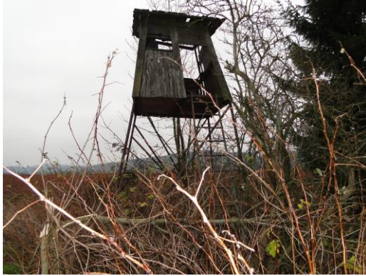
Příloha 28 a 29 Kazatelna a její podlaha za hranicí životnosti (č. 5 v honitbě Stružinec).
