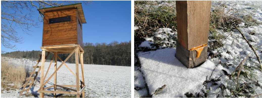
Příloha 18 Jedna z pěti kazatelen v honitbě Libštát (č. 20) opatřená ochranným nátěrem.
