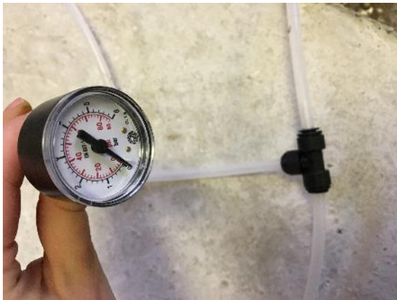
Obr. 60 – Vyobrazenie pripojenia meriaceho manometra na injektážnu hadičku pre zachytenie vstupného tlaku vody, ktorá vchádza do skúšobného bloku [zdroj:autorka]
