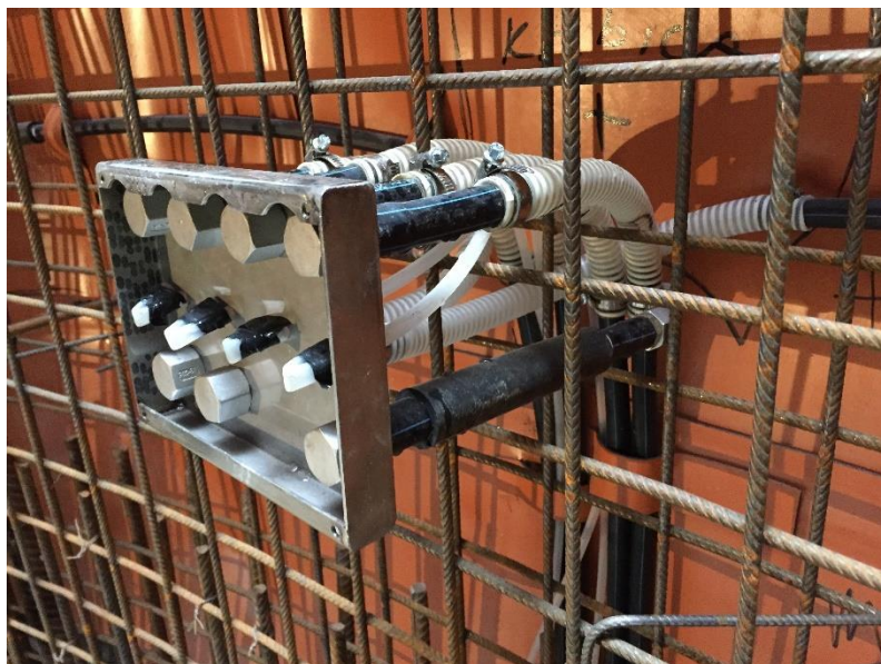
Obr. 28 – Usporiadanie injektážnych hadičiek v nerezovom injektážnom boxe podľa výkresovej dokumentácie [25]
