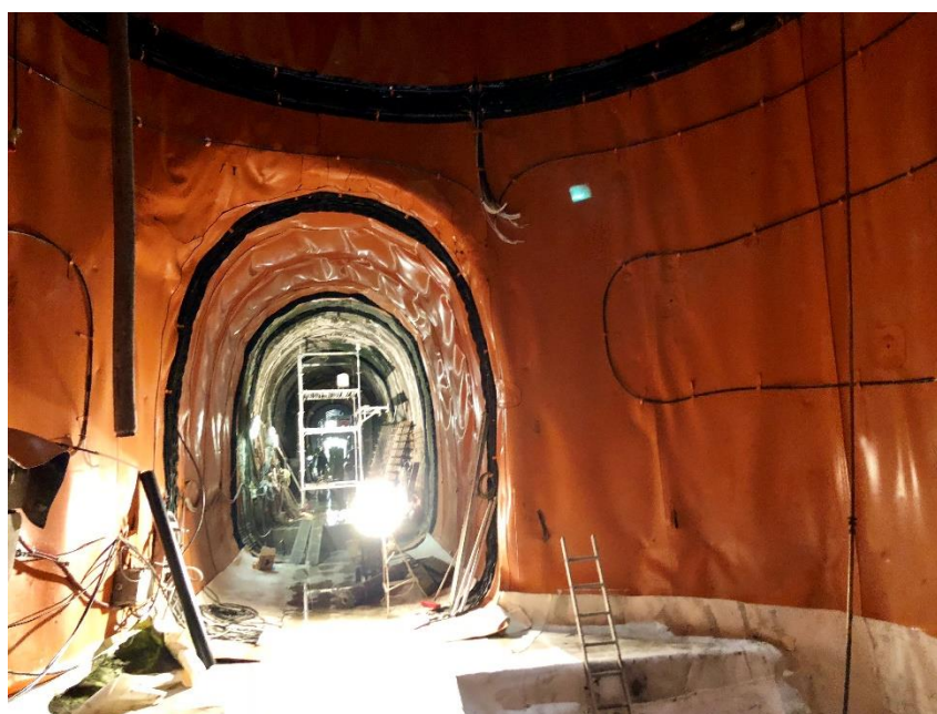
Obr. 27 – Zachytenie nainštalovanej hydroizolácie šachty J102, kde na dno bola nainštalovaná ochranná geotextília s plošnou hmotnosťou 2000g/m 2 [25]
