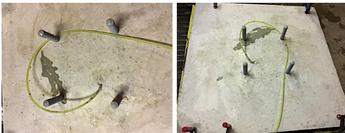
Obr. 64 – Zachytenie vytekajúcej vody cez praskliny v betónovom bloku pri tlaku vody 0,9 baru [zdroj:autorka]
