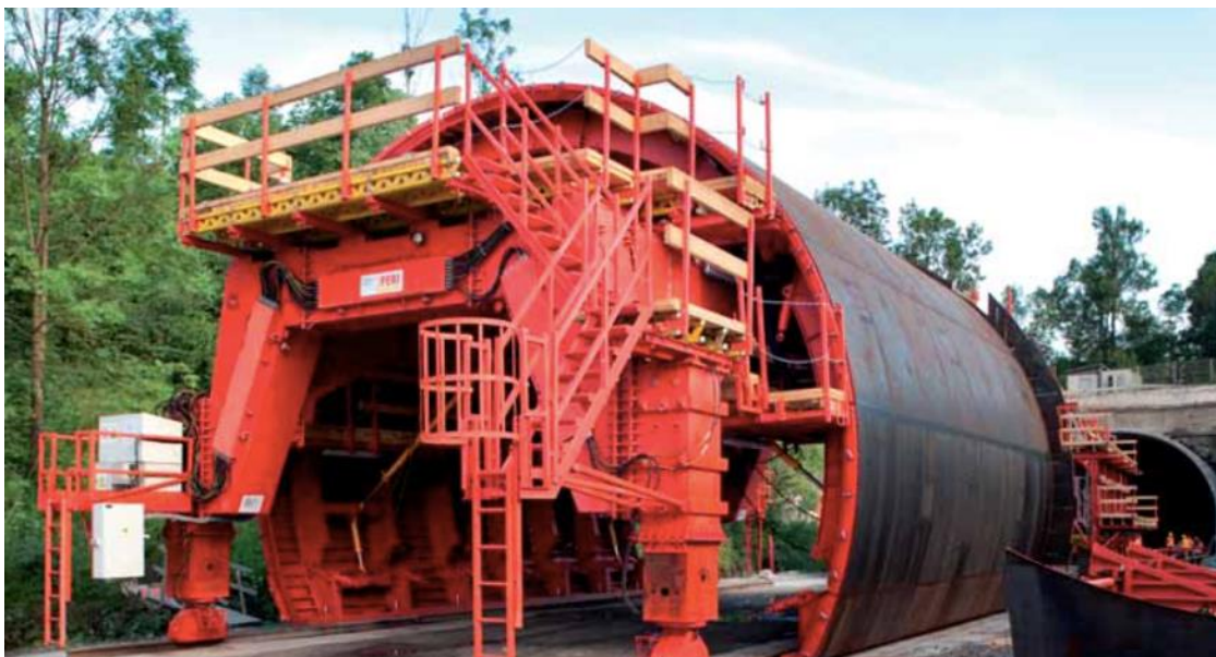
Obr. 8 – Fotografia bežne používanej ocelevej bedniacej formy zostavenej pre realizáciu sekundárneho ostenia [31]
