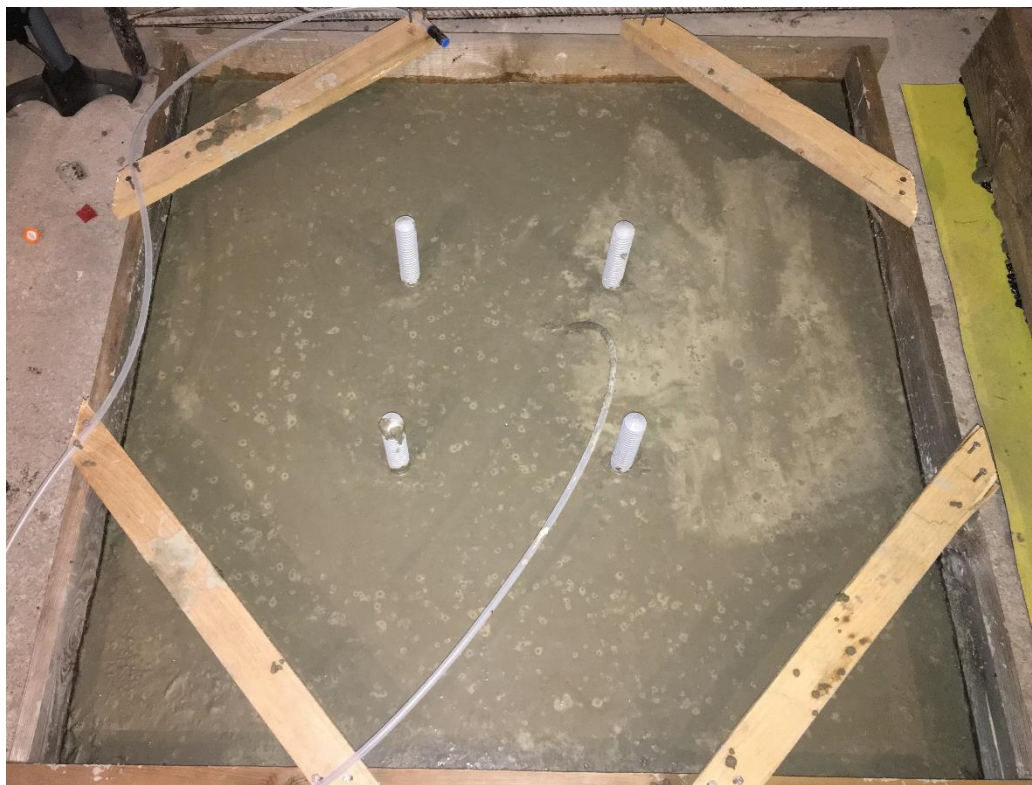
Obr. 59 – Fotografia skúšobného bloku po prevedení betonáže [zdroj:autorka]
