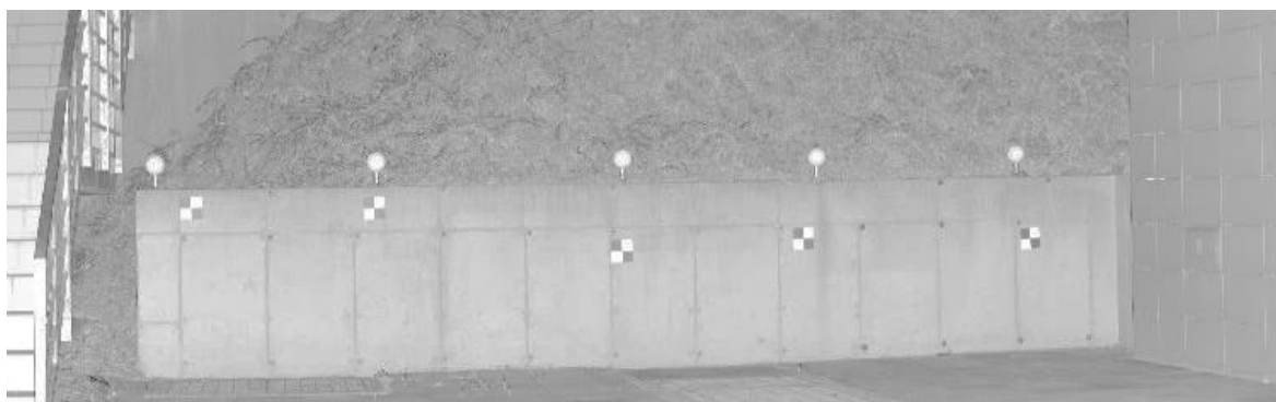
Obr. 8.3. Rozmístění umělých cílů na opěrné zdi
