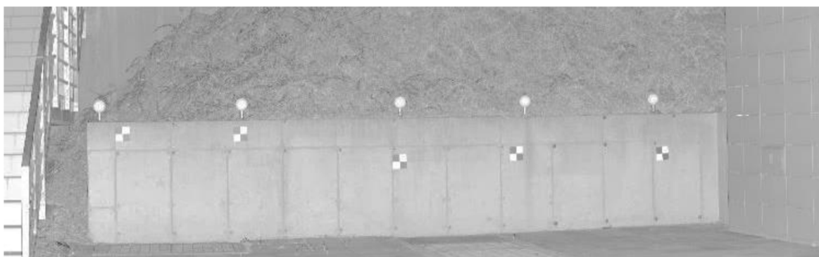
Obr. 8.3. Rozmístění umělých cílů na opěrné zdi
