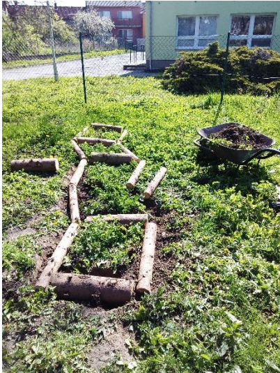
Budování hmatového chodníku
