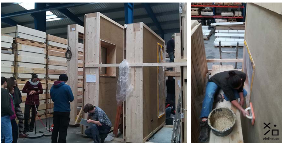
Obr. 8, 9: Workshop projektu Vivi House, TU Wien 2019 – stěnové panely, filcování omítek.
