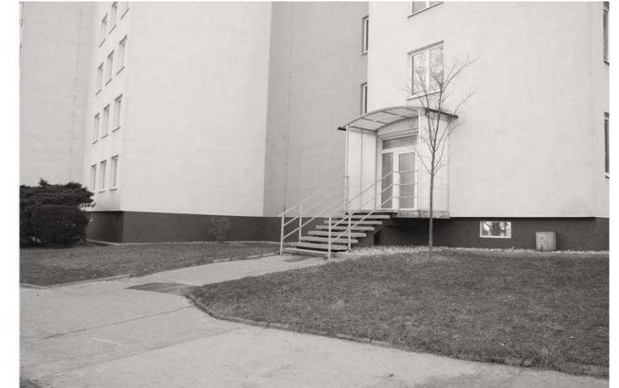
Obr. 82: Hlavní vstup – současný stav
