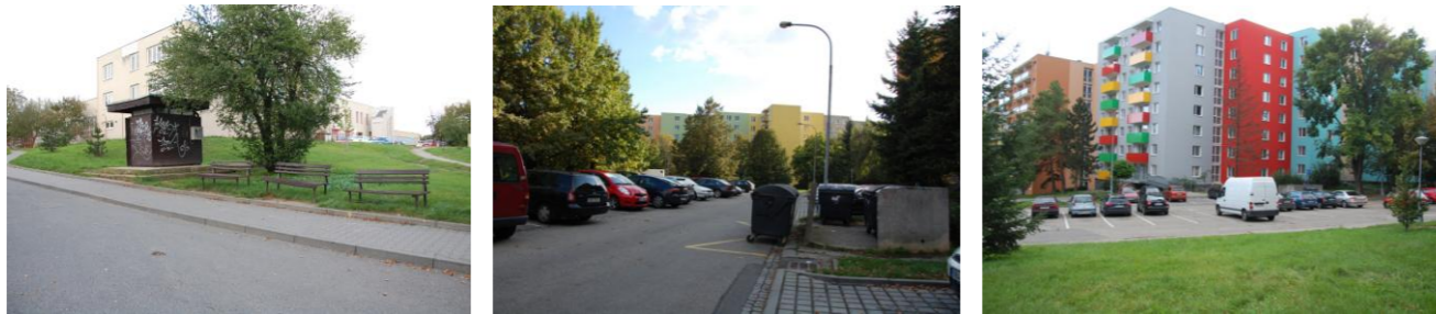
Zleva: Obr. 41: Znamky vandalství, Obr. 42: Nesnadná orientace, Obr. 43: Přemrštěná barevnost fasád
