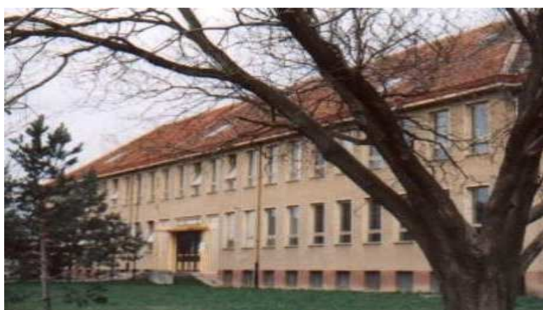
Obr. 7-2: Stav budovy před rekonstrukcí
