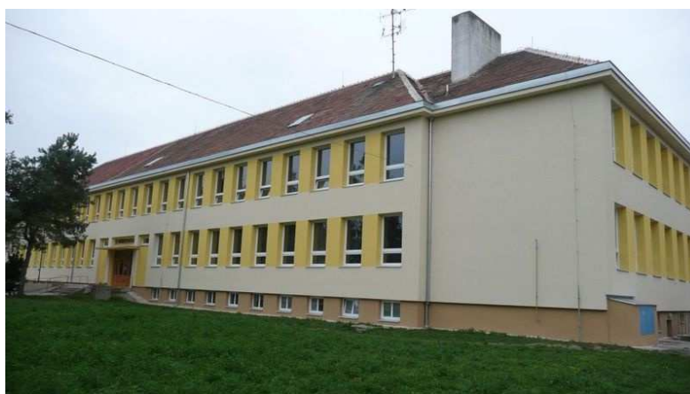
Obr. 7-3: Stav budovy po rekonstrukci
