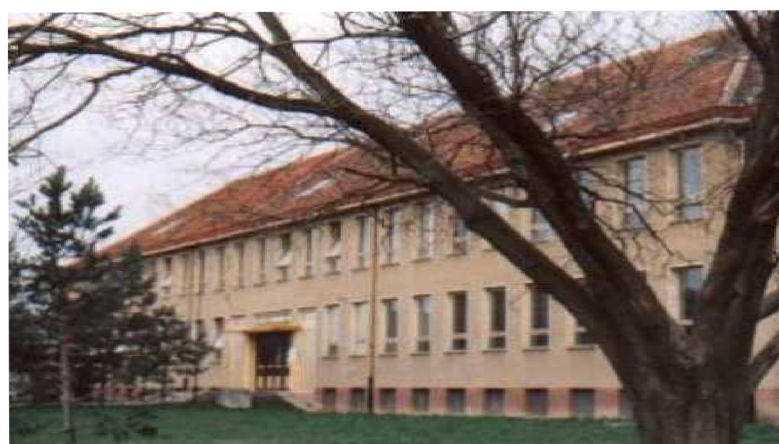
Obr. 7-2: Stav budovy před rekonstrukcí
