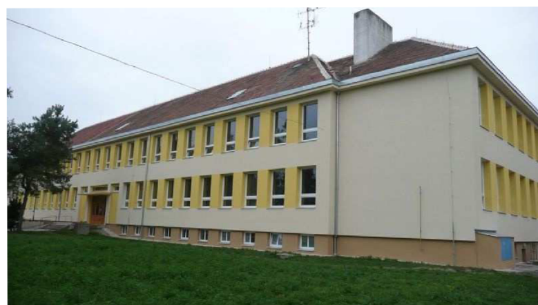
Obr. 7-3: Stav budovy po rekonstrukci
