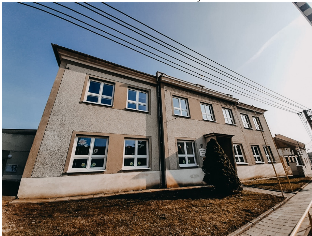
Budova základní školy
