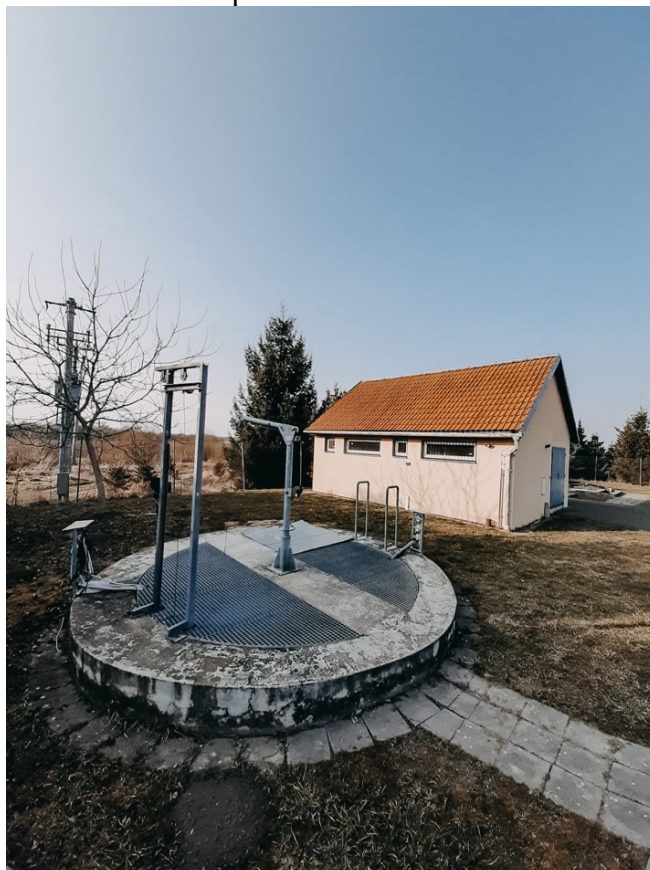
Čistička odpadních vod v Otonovicích
