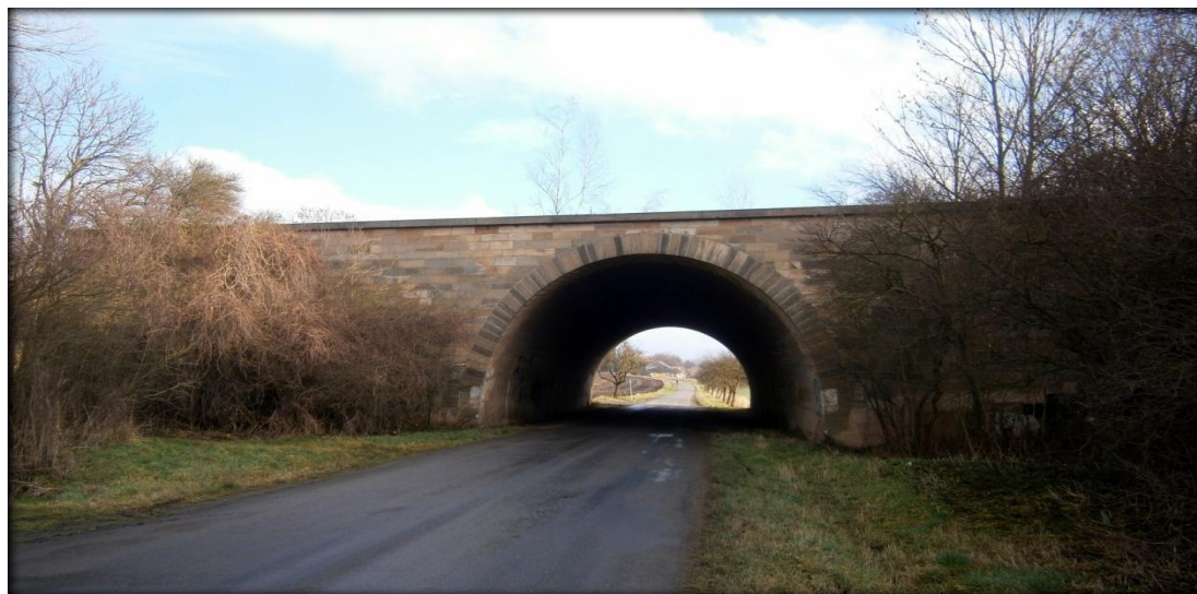
Obrázek 44: Most přes silnici Jevíčko - Smolná. Foto: Autor, 2013.
