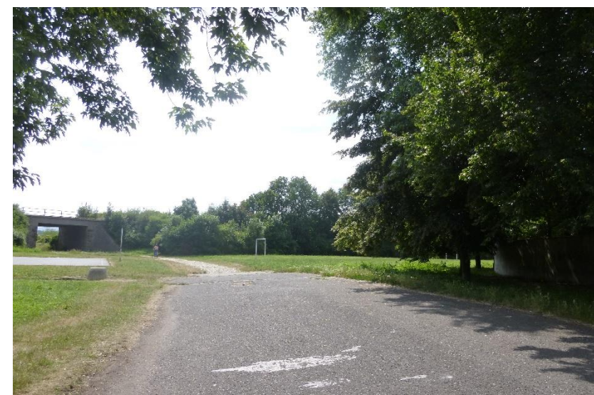
Obr. 175: Pohled duchcovský viadukt, kterým vede cesta do řešeného území.
