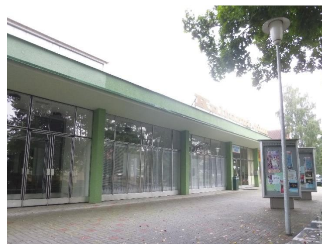
Obr. 121: Pohled na kulturní dům, který jako takový i jeho okolí bylo hodnoceno negativně.
