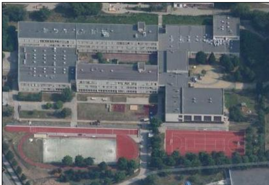
Obrázek 4 – 3: Areál Základní školy Svážná 9, Brno
