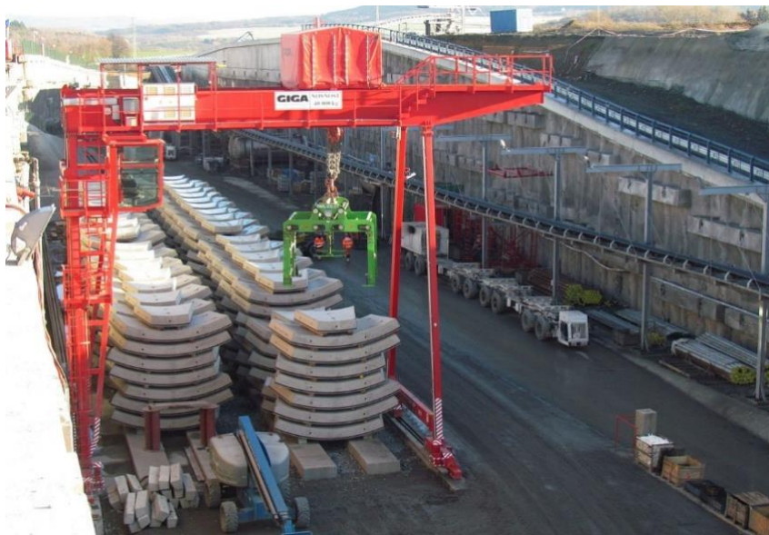
Obrázek 15 Betonové tibingy [22]
