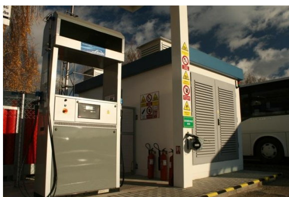
Obrázek 4 Čerpací stanice vodíku v Neratovicích [26]
