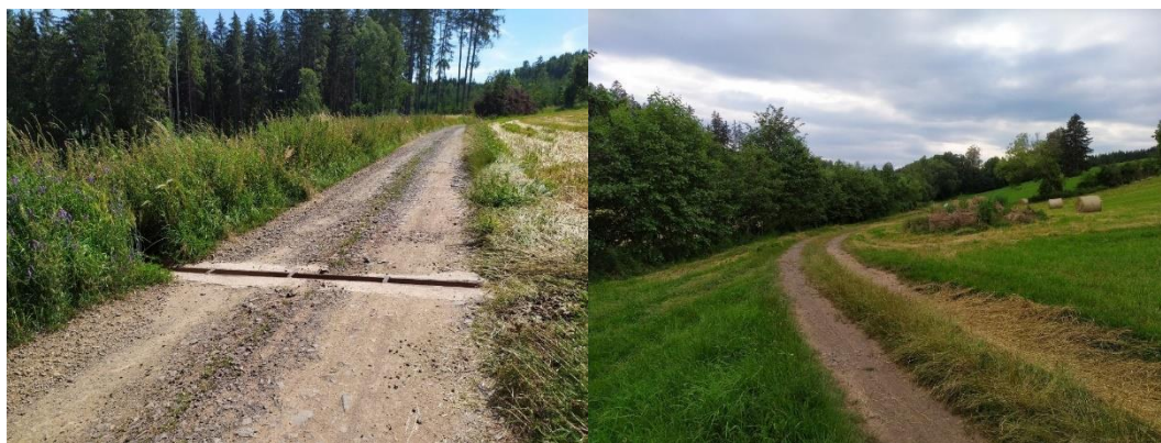
Obr. 27: HC36, povrch v blízkosti napojení na III/28311 (vlevo), pohled na doprovodnou zeleň vodního toku IDVT10180543 (vpravo)
