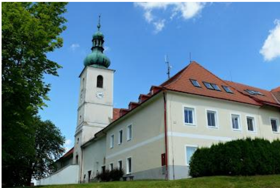
Obr. č. 56.: Kostel sv. Jana Nepomuckého ve Svatý Jan nad Malší, věž v západním průčelí, 1778-82
