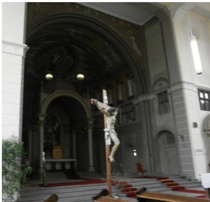
Obr. č. 91.: Kostel sv. Jana Nepomuckého v Českých Budějovicích, 1914 – 1915, Antonín Möller, kněžiště
