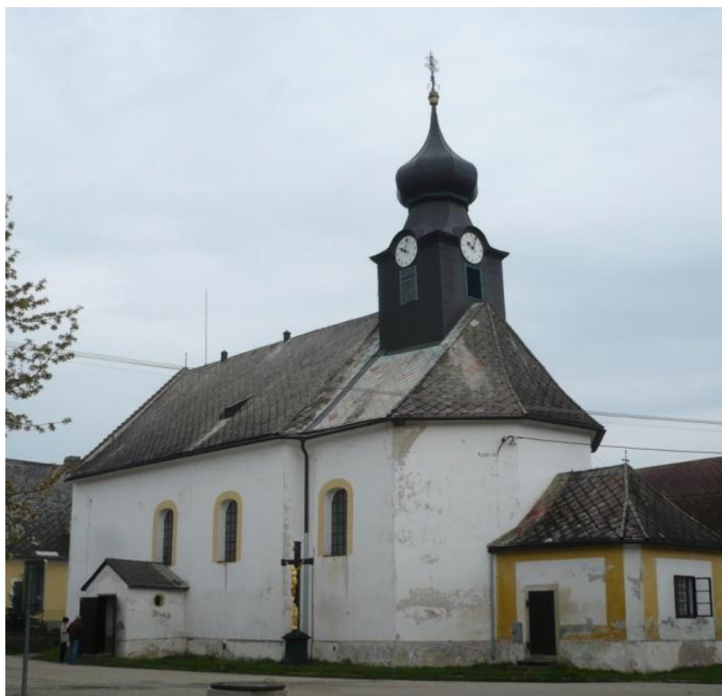
Obr. č. 63.: Kostel sv. Jana Nepomuckého v Člunku, 1787, presbytář zvenčí
