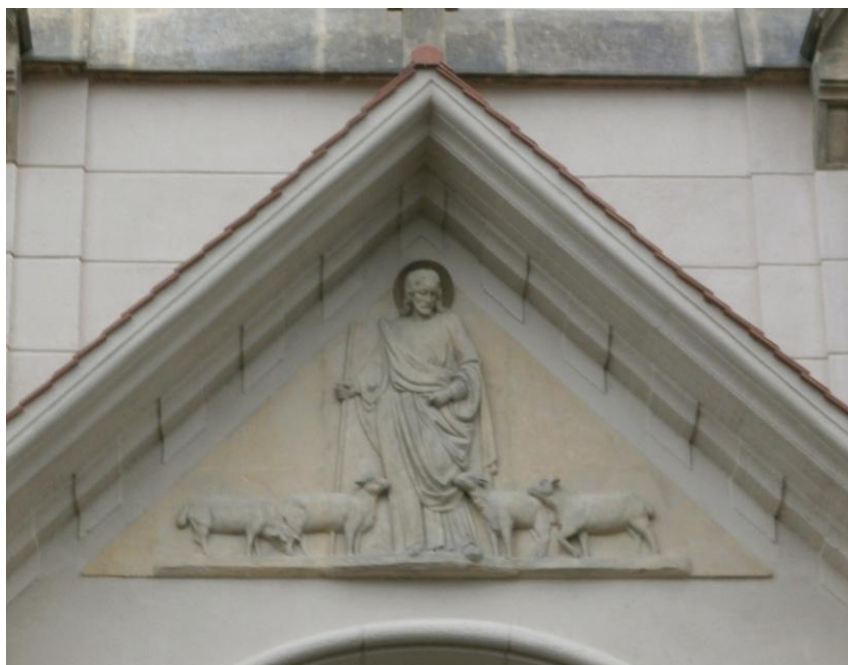
Obr. č. 89.: Kostel sv. Jana Nepomuckého v Českých Budějovicích, 1914 – 1915, Antonín Möller, vstupní portál
