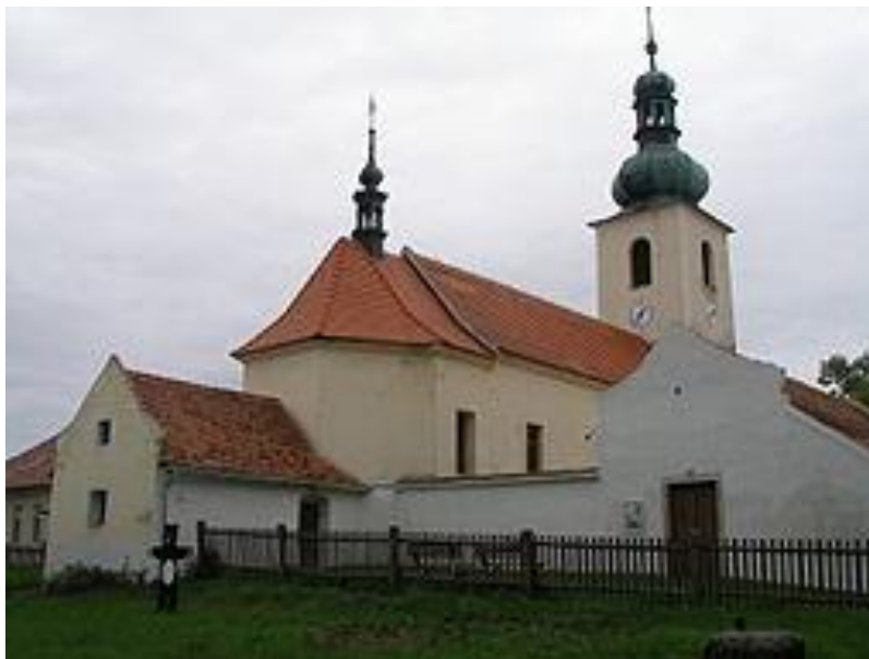
Obr. č. 54.: Kostel sv. Jana Nepomuckého ve Svatý Jan nad Malší, pohled na kostel, celkový pohled na kostel, 1778-82
