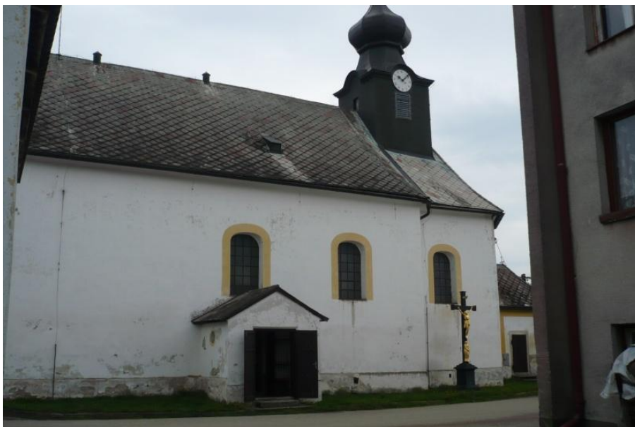
Obr. č. 62.: Kostel sv. Jana Nepomuckého v Člunku, 1787, celkový pohled na kostel
