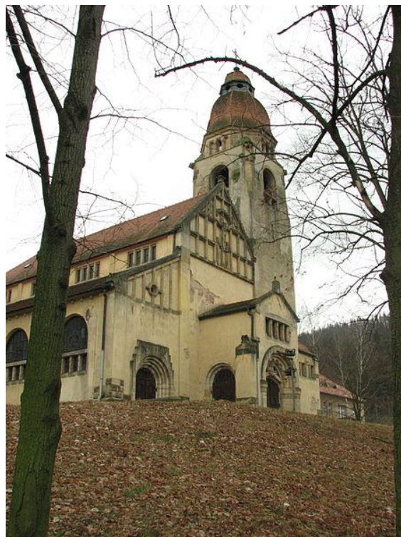
Obr. č. 33.: Farní kostel ve Štěchovicích, 1911-1914
