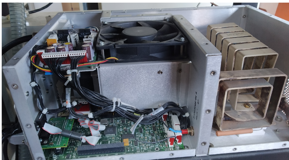
Obrázek 2.17: Automatická přizpůsobovací jednotka
