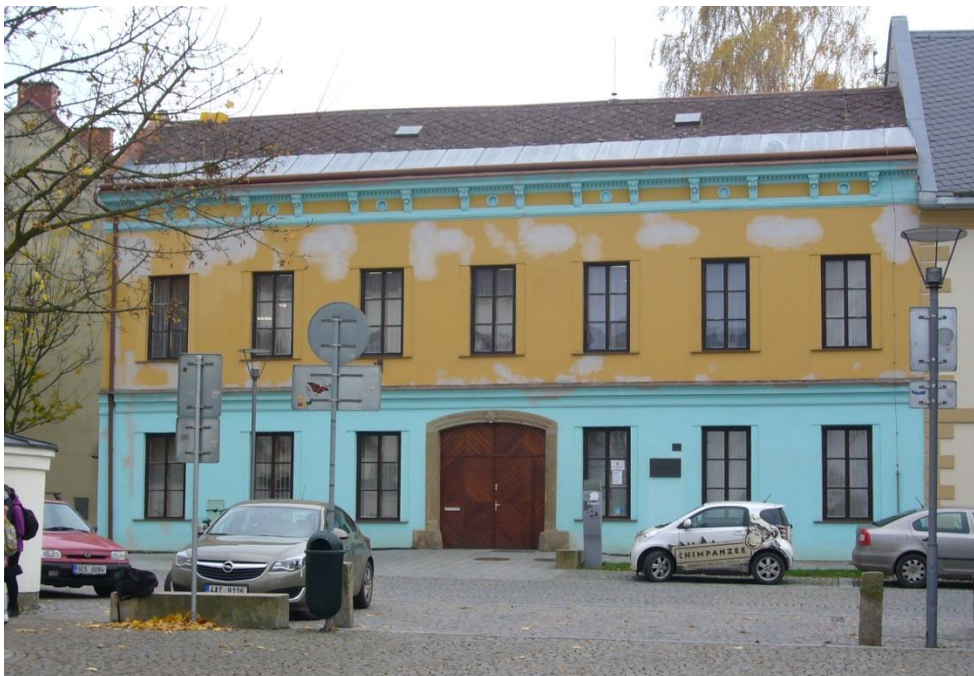
Lanškroun, budova městské knihovny čp. 142, rok 2016 – stav před obnovou
