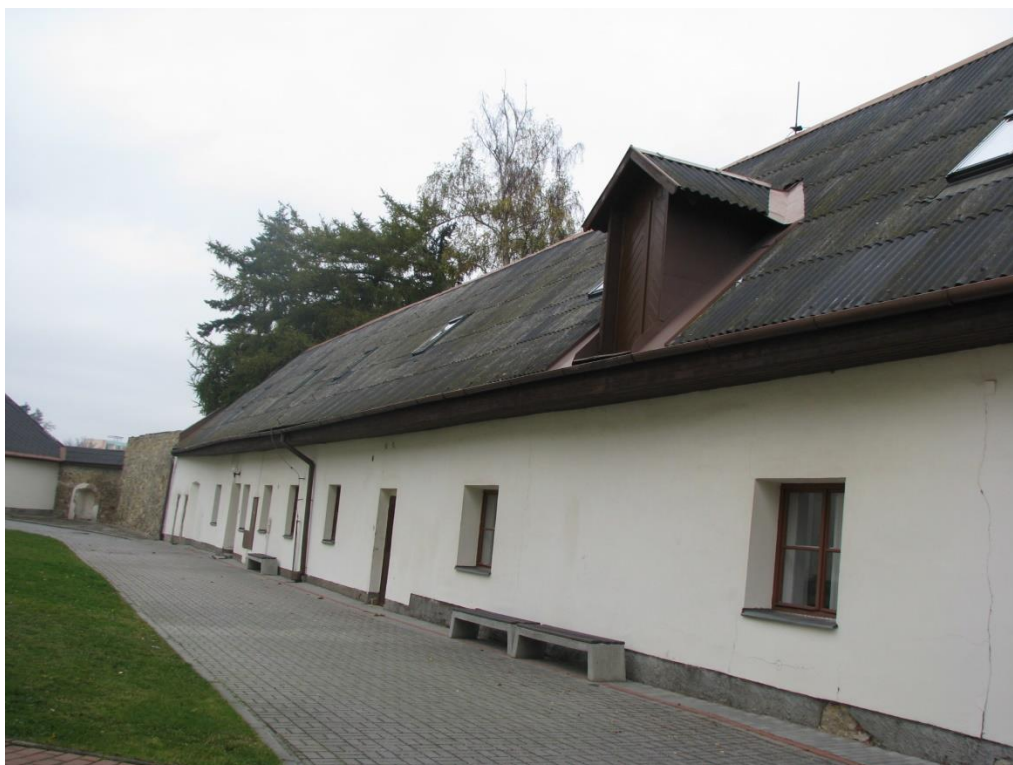
Lanškroun, budova konírny v areálu zámku čp. 1, rok 2008 – stav před obnovnou
