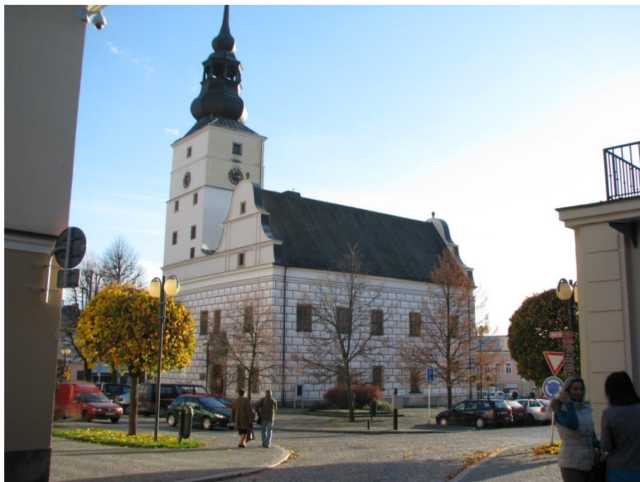
Lanškroun, budova radnice čp. 5, rok 2013 – stav před obnovou
