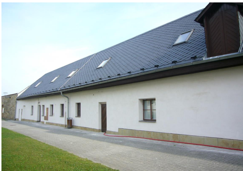
Lanškroun, budova konírny v areálu zámku čp. 1, rok 2021 – stav po obnovně
