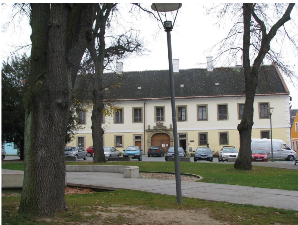
Lanškroun, budova děkanství čp. 2, rok 2008 – stav před obnovou
