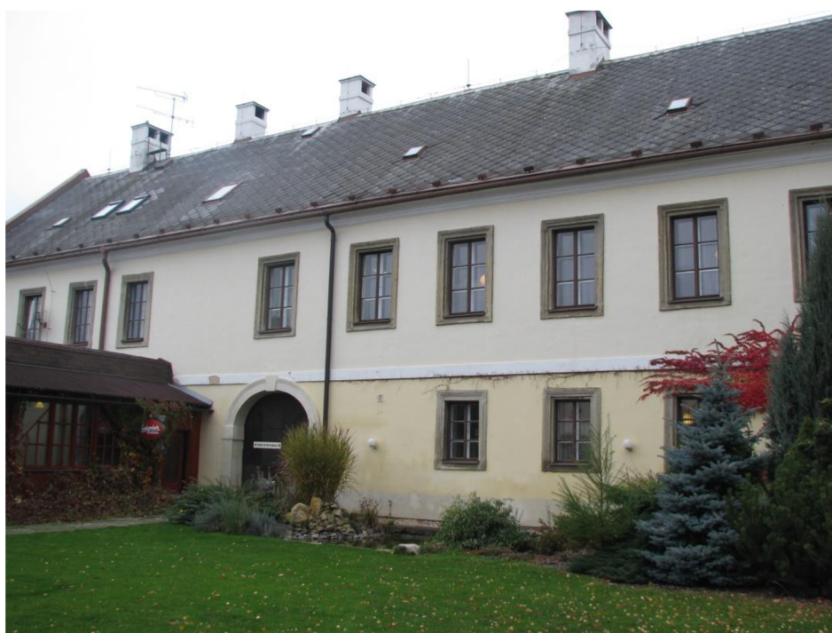
Lanškroun, budova děkanství čp. 2 - dvorní průčelí, rok 2008 – stav před obnovou
