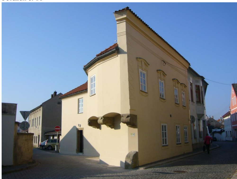
Lanškroun, dům „Piano“ čp. 202, rok 2018 – stav po obnově
