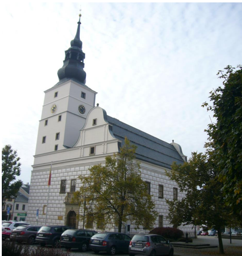
Lanškroun, budova radnice čp. 5, rok 2021 – stav po obnově
