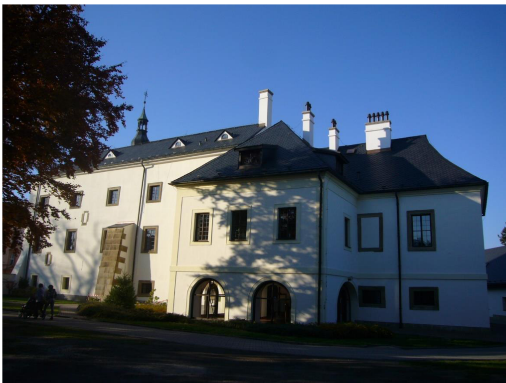
Lanškroun, budova zámku čp. 1, rok 2015 – stav po obnově
