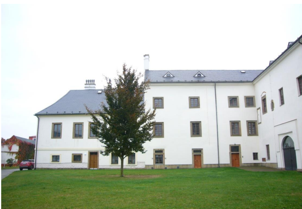
Lanškroun, budova zámku čp. 1 – nádvoří, rok 2021 – stav po obnově
