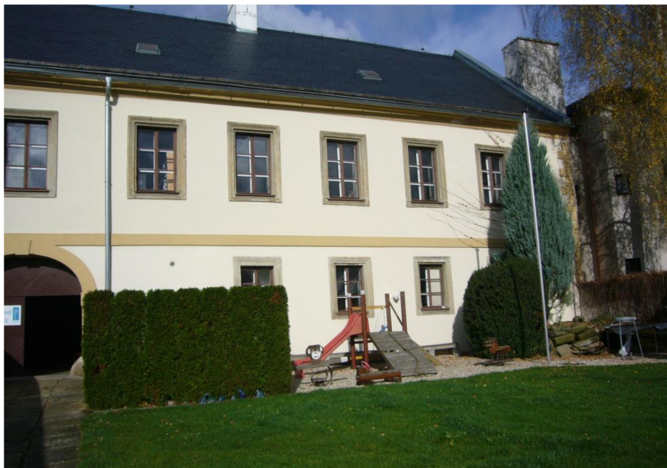
Lanškroun, budova děkanství čp. 2 - dvorní průčelí, rok 2017 – stav po obnově
