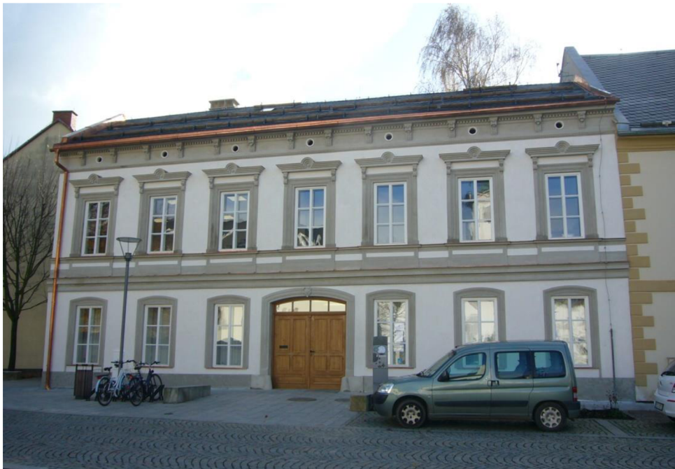
Lanškroun, budova městské knihovny čp. 142, rok 2017 – stav po obnově
