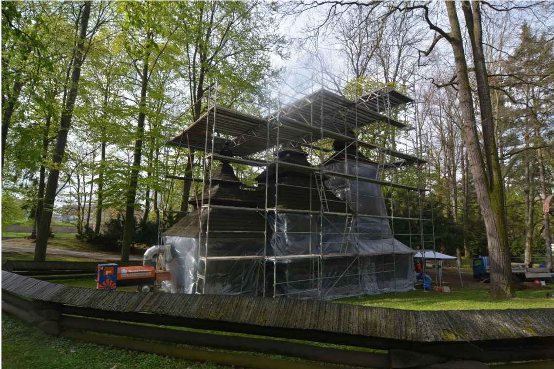
Obr. 15 Kostel při termosanaci v roce 2016. Zdroj: Magistrát města Hradec Králové.
