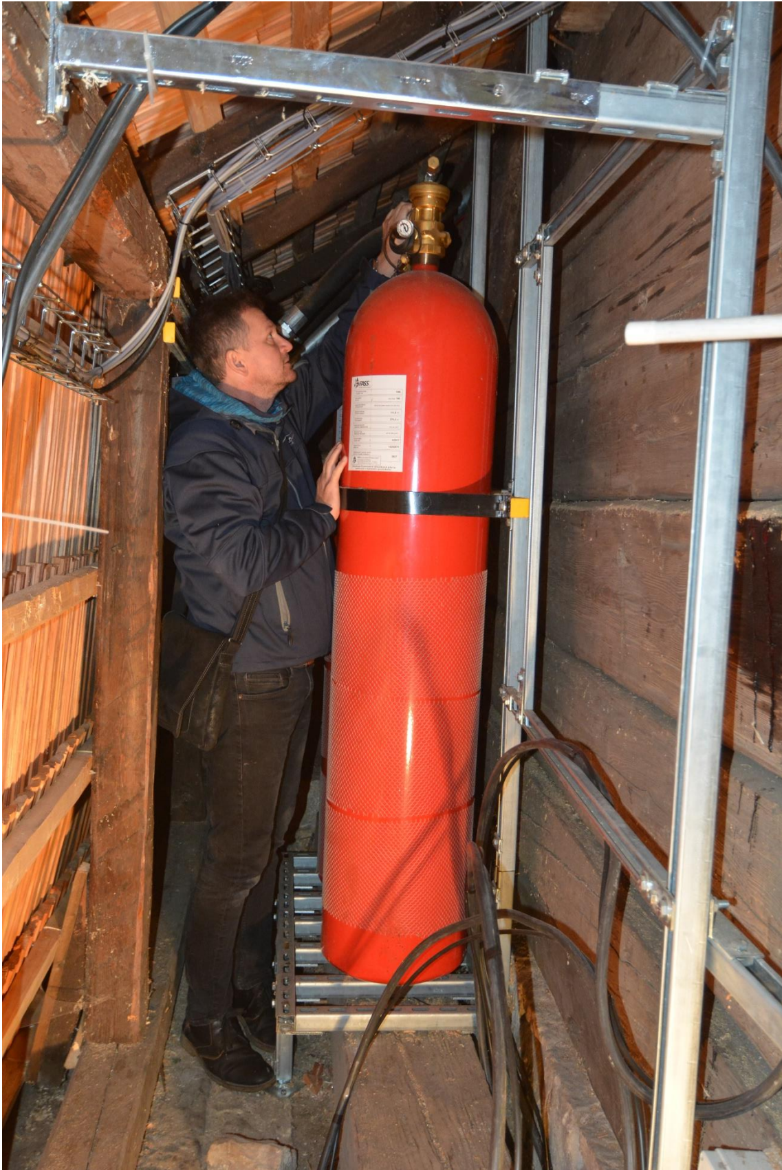
Obr. 19 Instalace protipožárního systému roce 2018. Zdroj: Magistrát města Hradec Králové.
