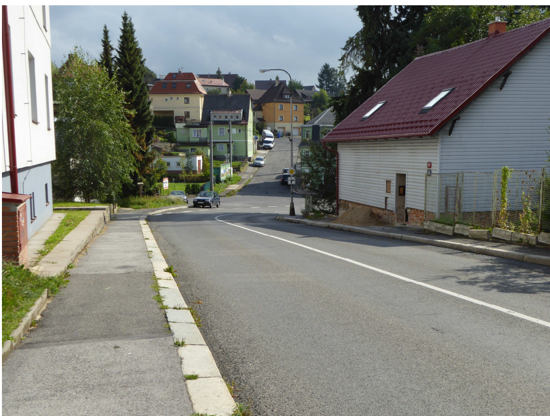
Obr. 4: Ul. Ruprechtická – pohled na řešenou křižovatku ze severní strany
