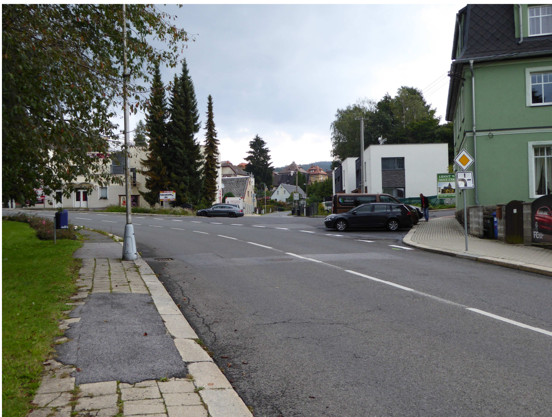
Obr. 5: Ul. Ruprechtická – pohled na řešenou křižovatku z jihozápadní strany
